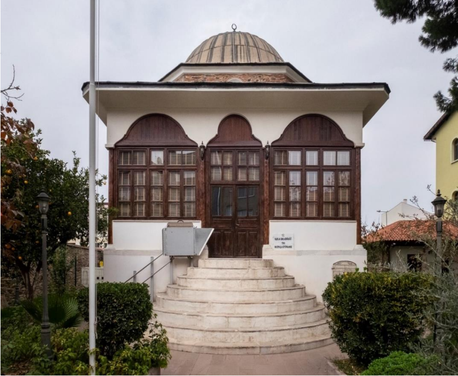
Fotoğraf 1: Necippaşa Kütüphanesinin Güney Cephesinden Bir Görüntü (Kişisel Arşiv, 2023)
