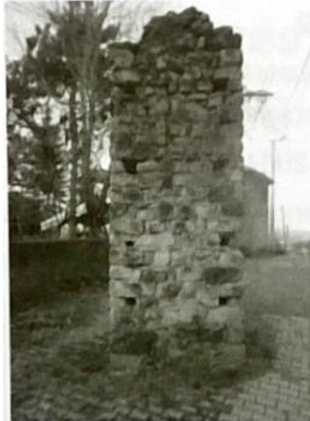
Şekil 11. Kemerde iskele boşlukları (Gap of scaffold in aqueducts) [11]
