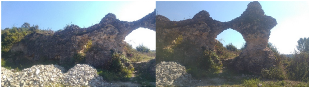
Şekil 14. Farklı açılardan çekilmiş yıkılmış tarihi Roma dönemi Su kemeri yapıları (Aqueducts collapsed and various views in Roman period)
