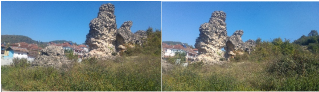
Şekil 13. Depremlerde yıkılmış Roma dönemi su kemerleri (Aqueducts collapsed due to historical earthquakes in Roman period)
