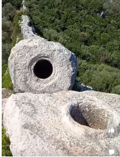
Şekil 7. Düzgün meyilli arazide cazibeli su kanalı (Straight smooth water channel with gravity in site)
