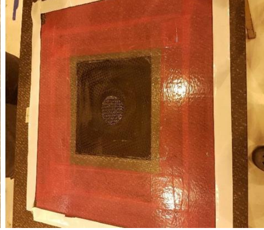
Şekil 9: Tamir uygulandıktan sonra hasarlı bölgeye ıslak serim yapılmış görüntüsü
