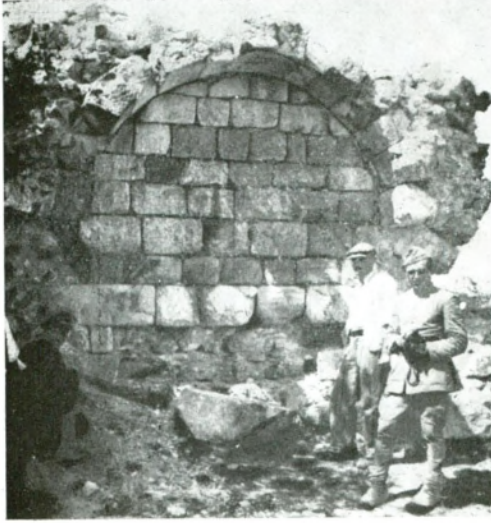
Res. 9 a — Arabacı kapı civarındaki Niş.
