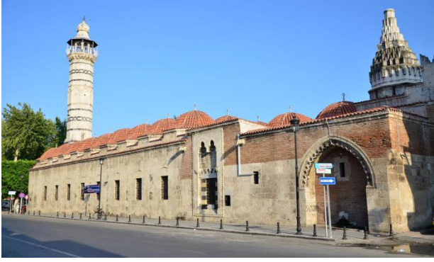
Görsel 13: Adana Ulu Camii'nin Genel Görüntüsü ve Batı Taç Kapısında bulunan Mukarnas Detaylı Kubbesi https://okuryazarim.com/adana-ulu-cami/ 25. 10.2022.
