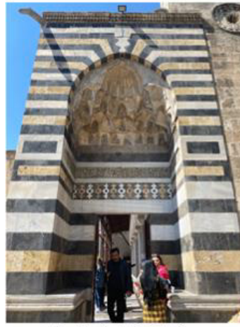
Adana Ulu Camii Doğu Taç Kapısı
