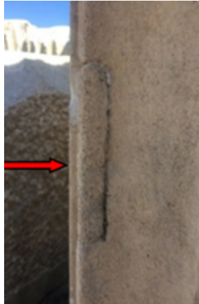
Resim 2. Sütun Tamburundaki Antik Onarım, Aynı Taş Harçlı Bitiştirme Detayı 8 .
