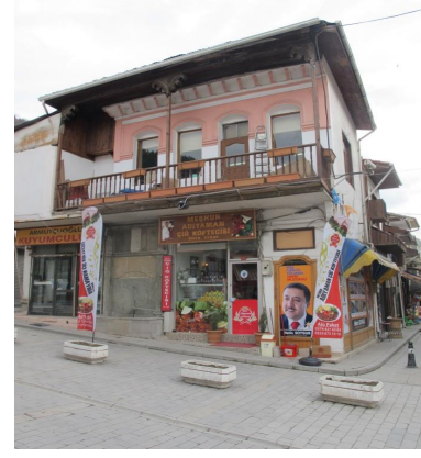
Şekil 16. 111 envanter no'lu ticari yapı ve çeşme 13
