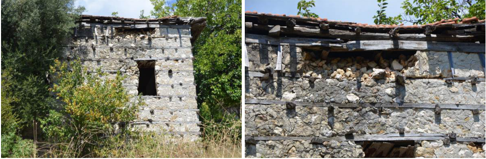
Fot. 5-6: Güçlüköy Camisi Güney Cephe
