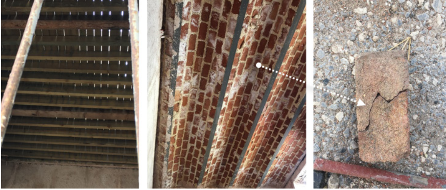
Görsel 19: Yapı içerisinde görülen döşeme örnekleri; ahşap döşeme, volta döşeme ve volta döşeme dolu harman tuğlası (2022)
