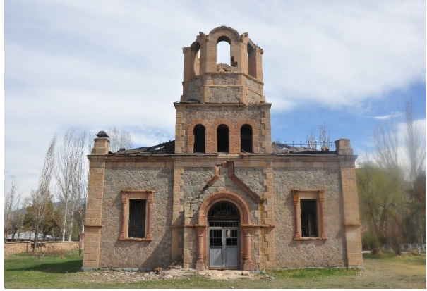
Görsel 19: Batı Cephe
