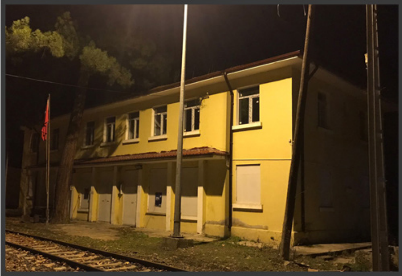
Görsel 10. Cildikısık tren istasyonu istasyon binası (2021)
