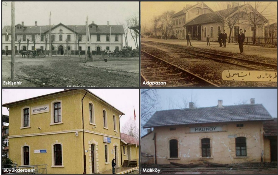
Görsel 3. Anadolu Demiryolu hattı üzerinde tip proje ile inşa edilmiş istasyon binası örnekleri (URL 5, 2022; URL 6, 2022; URL 7, 2023; URL 8, 2023)
