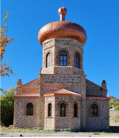
Görsel 21: Restorasyon Sonrası Doğu Cephe
