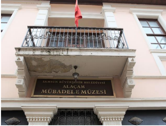
Fot. 8: Burhaniye İbtidai (Sıbyan) Mektebi ön cephe balkon ve çevresi
