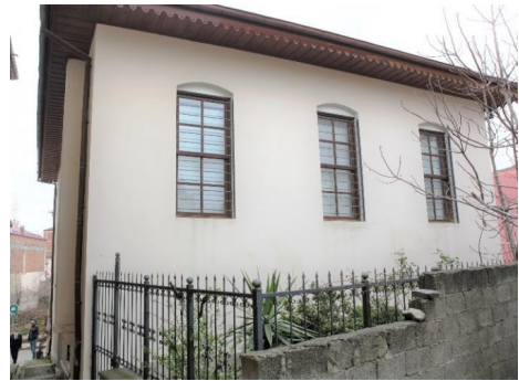
Fot. 5: Burhaniye İbtidai (Sıbyan) Mektebi güney cephe
