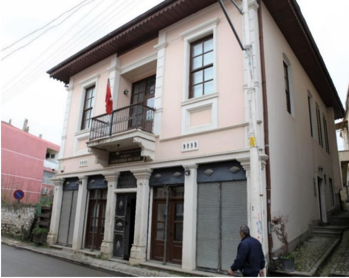
Fot. 3: Burhaniye İbtidai (Sıbyan) Mektebi ön (kuzey) cephe
