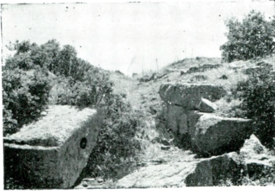
Resim 6 — İzmir Kalesi, Yapı temelleri.
