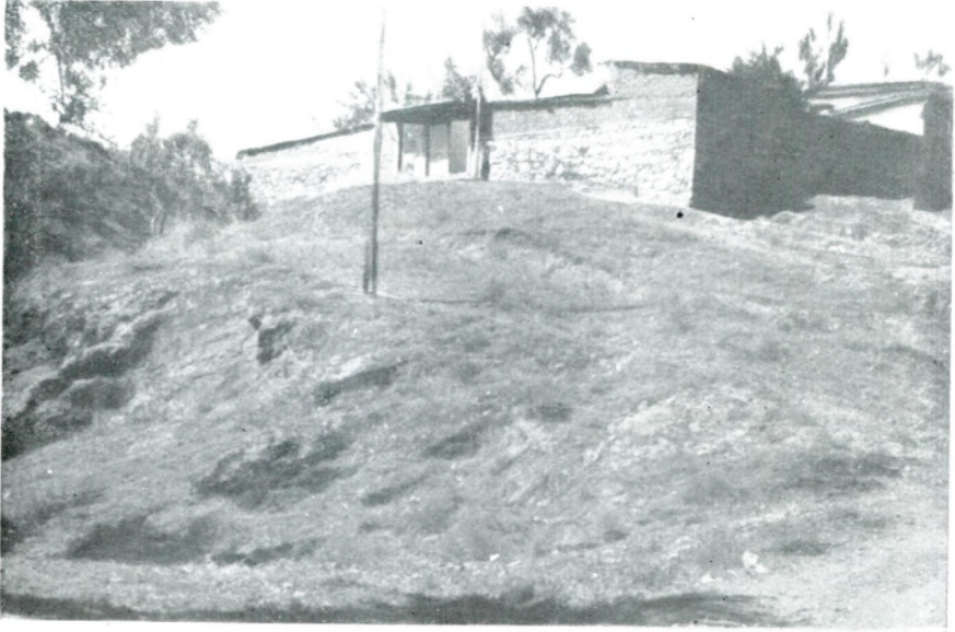
Res. 5 — Mezar binasını ihtiva eden bahçenin duvarları
