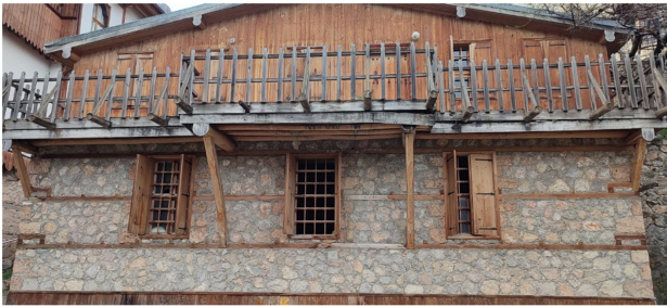
Görsel 6. Değirmen doğu cephesi.
