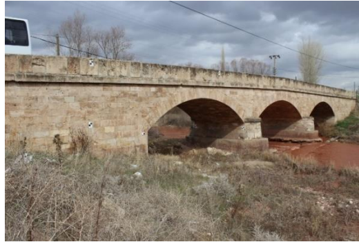
Foto.3. Fadlum Köprüsü Genel Görünüş (Elmas Ş. P.)
