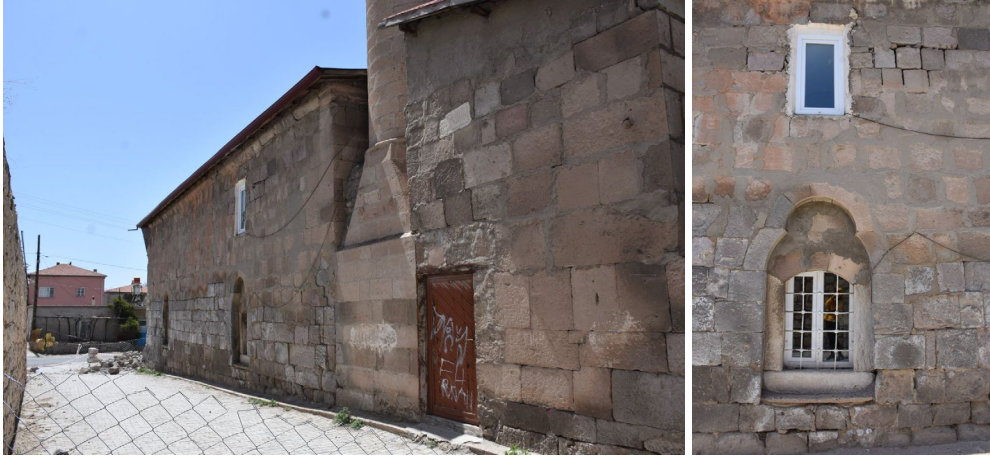
Şekil 6. Doğu Cephesi ve Pencere Detayı, 2019
