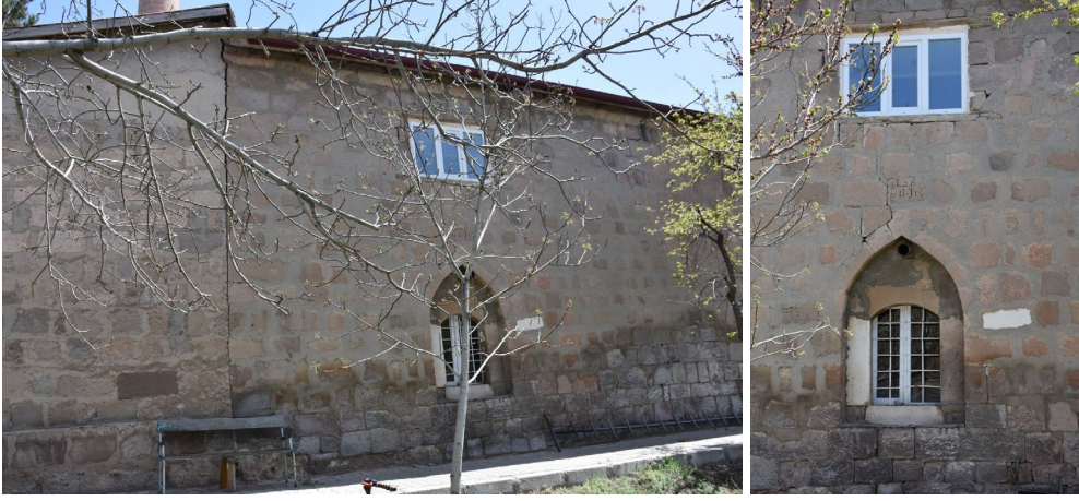
Şekil 7. Batı Cephesi ve Pencere Detayı, 2019
