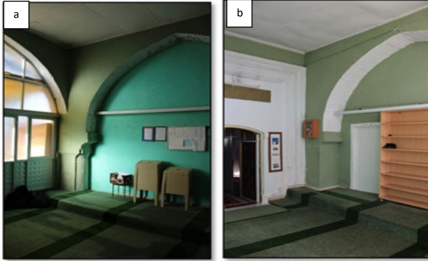
Şekil 22. Son Cemaat Bölümünde, Doğu (a) ve Batıda (b) Kapatılan Duvarlar ve Gergi Çubukları, 2020
