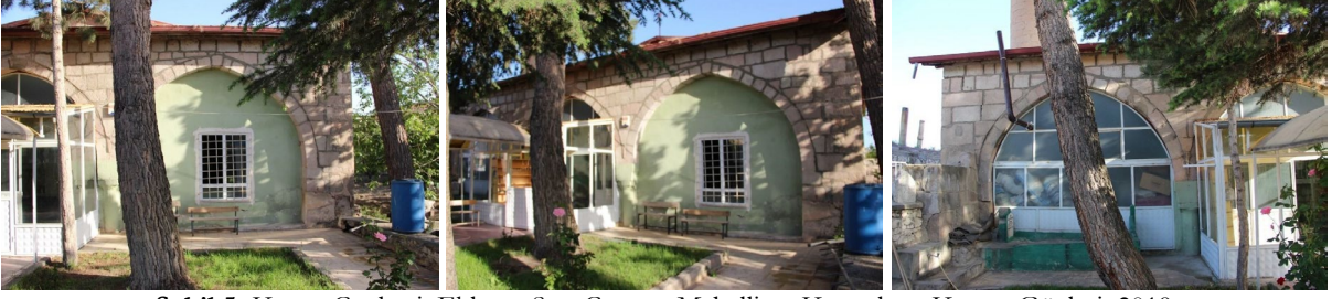
Şekil 5. Kuzey Cephesi, Ekleme Son Cemaat Mahalli ve Kapatılmış Kemer Gözleri, 2019
