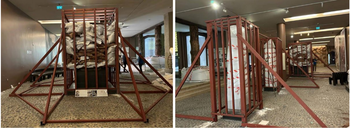
Fotoğraf 5. Önlem olarak yapılan çelik kafesler
