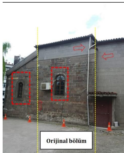
Görsel 4. Hatuncuk Hatun Cami'nin batı cephesi üzerindeki değişim izleri
