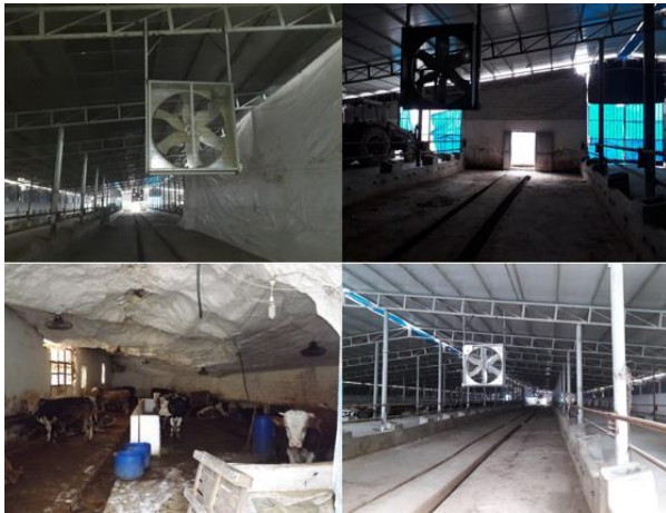
Şekil 11. Hava sirkülasyonunu hızlandırmak için vantilatör kullanan işletme örnekleri.
