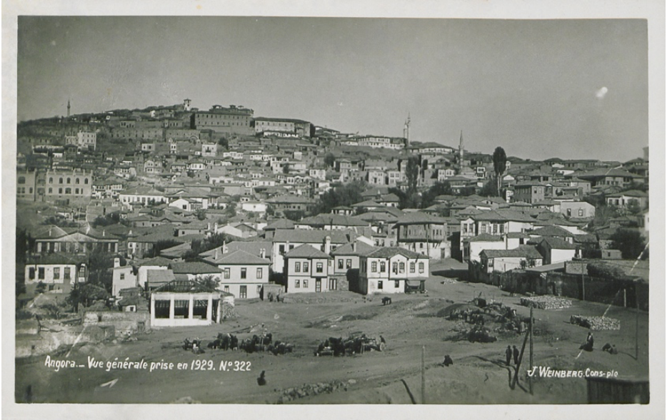
Şekil 6. Namazgah Tepesi'nden Yahudi Mahallesi'ne bakış, 1929.
