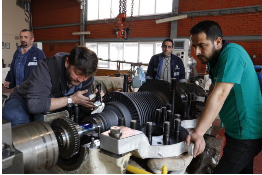
Fotoğraf 16. Enerji ünitesi revizyon, bakım çalışmaları, (Gülbin Özdamar Akarçay Arşivi).
