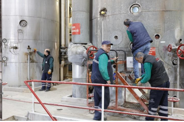
Fotoğraf 13. Kazanların revizyon döneminde bakımını yapan işçiler (Fabrika Fotoğraf Arşivi).
