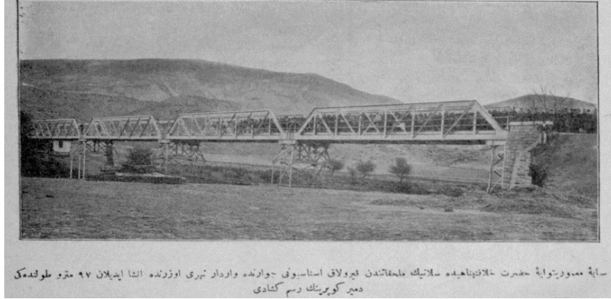
Resim 4: II. Abdülhamid Döneminde Vardar Nehri Üzerinde İnşa Edilen 97 Metre uzunluğundaki Demir Köprü
