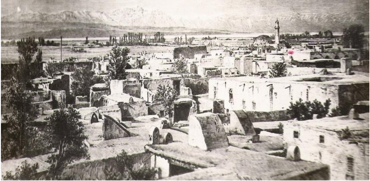
Şekil 41. Eski Van Şehri Sivil Mimarlık Yapıları Dam Başı Görünüşü (Kaynak: Anonim)
