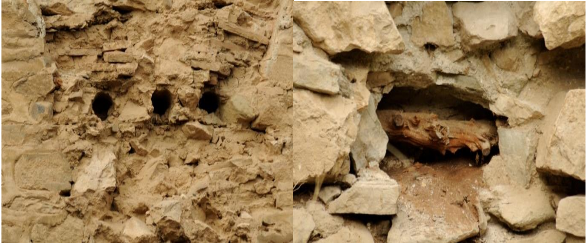
Şekil 47,48. Miri Ambarı Beden Duvarları Tomruk Ahşap Hatıl Görünüşleri (Kaynak: Ş. Öztürk, 2010).
