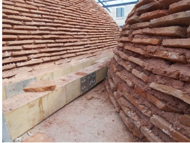
Şekil 4.1.5. Mısır Çarşısı Haseki kapısı üstü odaları kubbe ve tonoz kasnağı çevresine yerleştirilen hatıllar (Figure 4.1.5. Lintels placed around the tensile hoops region of dome and vault in the rooms above the Haseki gate of the Spice Bazaar)
