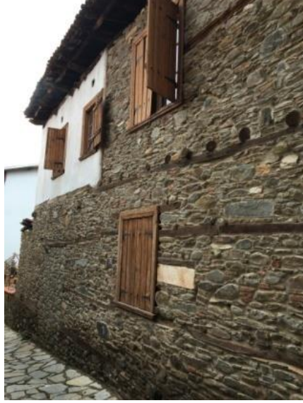
Şekil 3.3.1. Ahşap hatıl, Birgi, İzmir (Figure 3.3.1. Timber lintel, Izmir, Birgi)
