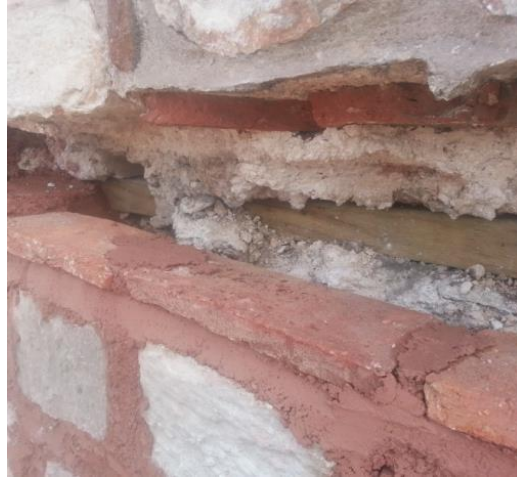
Şekil 4.1.3. Mısır Çarşısı duvarlarında metal plakalarla birleştirilen ahşap hatıllar ve sonrasında tuğla ve enjeksiyon harcı ile boşlukların kapatılması (Figure 4.1.3. Timber lintels joints with metal plates on the walls of the Spice Bazaar and then filling the gaps with bricks and injection mortar)
