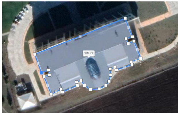
Şekil 3. Kütüphane çatı alanı Figure 3. Library roof area
