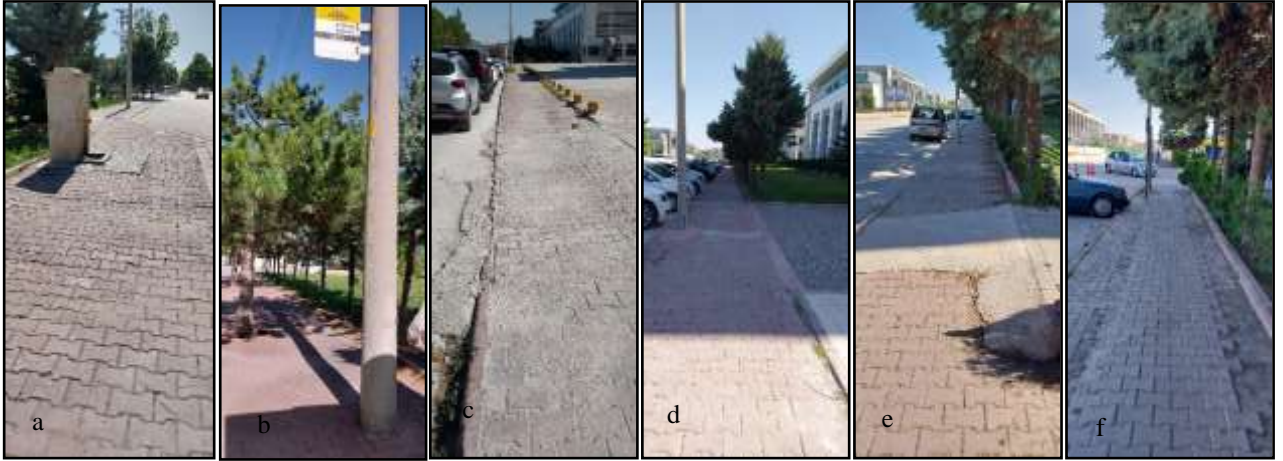
Şekil 25. B2 Güzergahının genel görünümü (Figure 25. General view of B2 Route)
