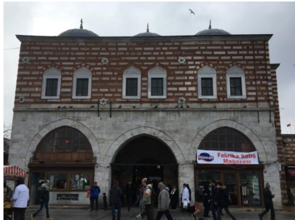
Şekil 4.1.7. Mısır Çarşısı Balıkpazarı Kapısı üstü odalarının paslanmaz çelik gergilerin cepheden görünüşü (Figure 4.1.7. Front view of the stainless steel tension rods of the rooms above the Spice Bazaar Balıkpazarı Gate)
