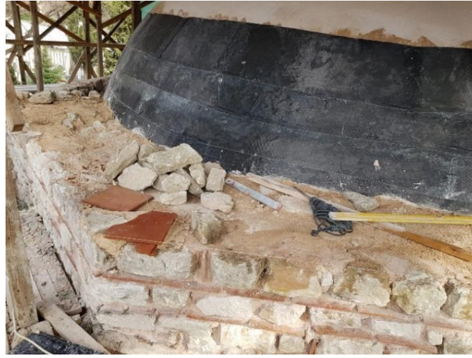
Şekil 4.2.5. Kubbe kasnağına uygulanan karbon elyaf kuşaklama (Figure 4.2.5. Carbon fiber reinforced polymer application in tension region of the dome)
