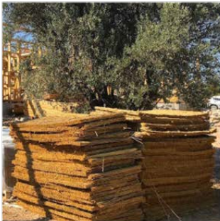
Şekil 10. Yapının kuzey ve doğu cephelerinde saz kamışı yalıtım uygulaması (URL-1).
