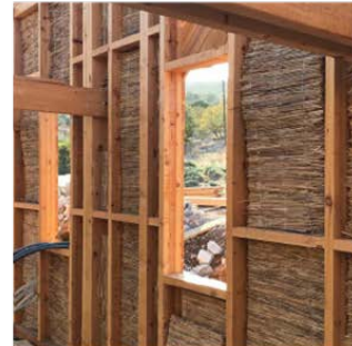
Şekil 10. Yapının kuzey ve doğu cephelerinde saz kamışı yalıtım uygulaması (URL-1).
