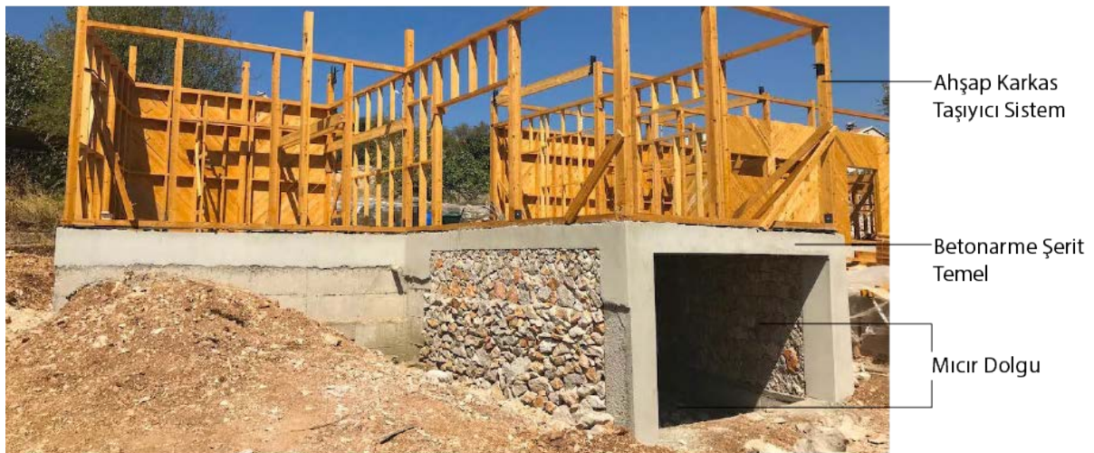
Şekil 4. Şerit temel, mıcır dolgu ve ahşap karkas taşıyıcı sistemin gösterimi (URL-1, Yazar, 2023).
