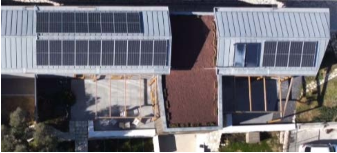
Şekil 19. Çatıda konumlanan fotovoltaik (PV) ve güneş panelleri (URL-1).
