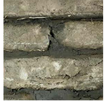
Kerpiç örümünde kil harç kullanımı
