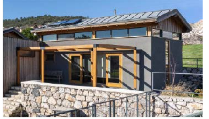
Kış günlerinde pergola üzeri saz kamışı örtüsünün kaldırılması
