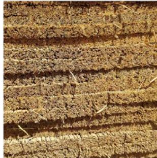
Şekil 10. Yapının kuzey ve doğu cephelerinde saz kamışı yalıtım uygulaması (URL-1).
