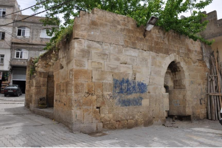
Fotoğraf 30. Meçan Kapısı – Arka Cephe, Kuzeybatı Köşesi
