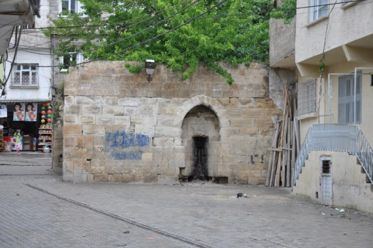
Fotoğraf 32. Batı Cephesi(Kapının Arka Cephesi) Niş ve İçerisindeki Mazgal Pencere
