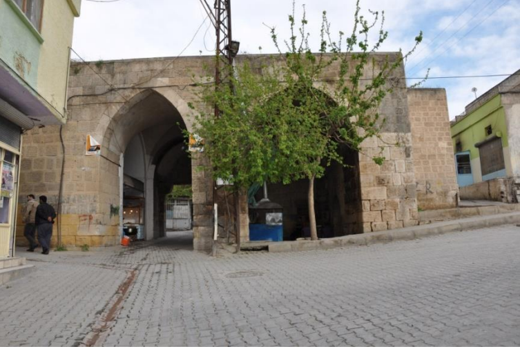
Fotoğraf 3. Batı Cephesi
