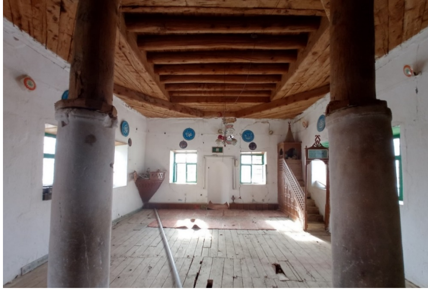
Fig. 17. Harim Güney Cephesine Genel Bakış (Demir Group Arşivi)
