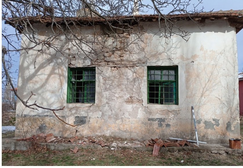
Fig. 8. Güney Cephe (Demir Group Arşivi)
