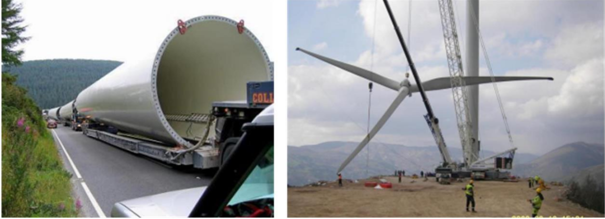
Şekil 2. Rüzgâr türbini ve kanatlarının taşınması ve tesis edilmesi [23]
