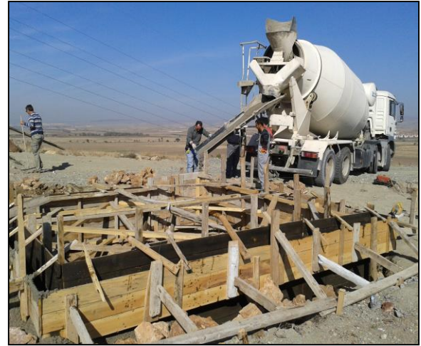
Şekil 7. Betonlama Çalışmaları Gösterimi
