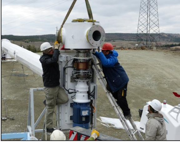
Şekil 9. Türbin Göbeği (Hub) Montaj Gösterimi
