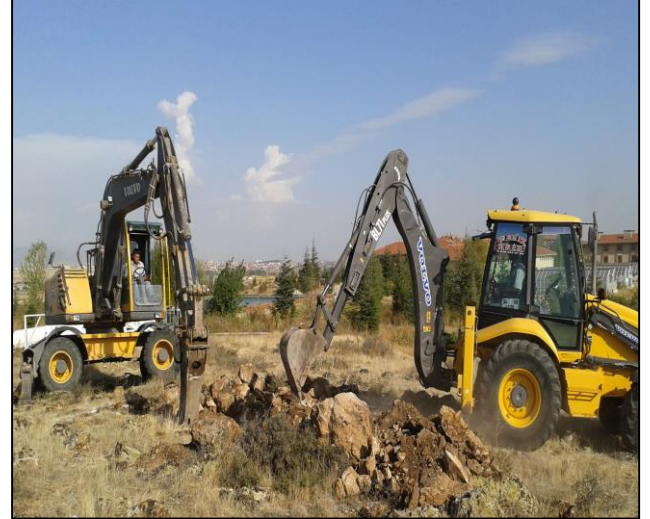
Şekil 6. Zemin Kazı Çalışmaları Gösterimi
