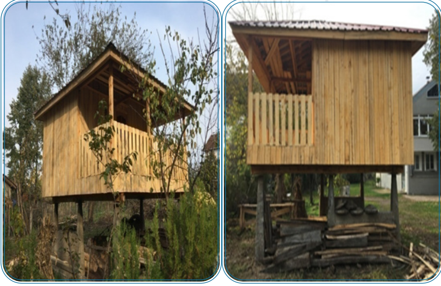
Resim 8: Gökçeada Mahallesi Yeni Serenderi Ön ve Yan Cephe
