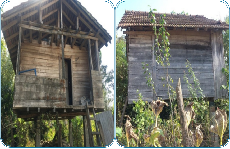
Resim 37: Altunlu Mahallesi Serenderi Ön ve Yan Cephe
