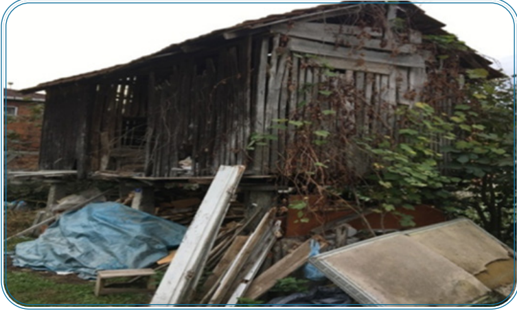
Resim 13: Evcı Mahallesi Kapalı Balkon Serenderi Yan Cephe
