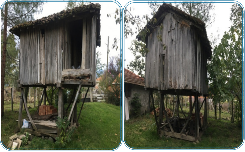
Resim 1: Mescitli Mahallesi En Eski Serenderi Ön Cephe ve Ayak Direkleri
