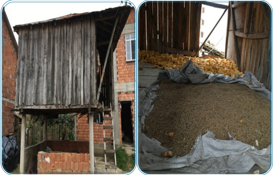
Resim 17: Evc Mahallesi Yeni Serenderi Yan Cephe ve İç Kısım
