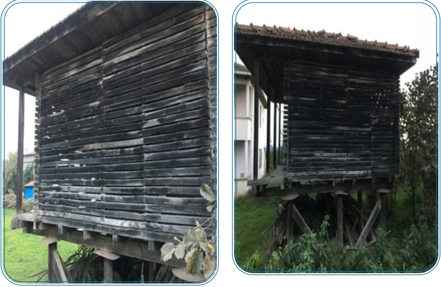
Resim 4: Mescitli Mahallesi Merkez Serenderi Yan Cephe
