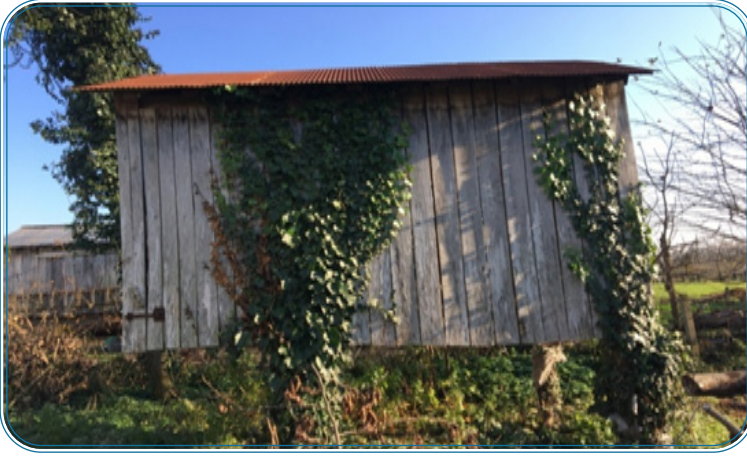
Resim 22: Sakarlı Mahallesi Serenderi Ön Cephe
