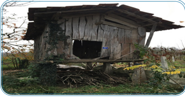
Resim 18: Evcı Mahallesi Serenderi Dört Ön Cepheden Görünüm
