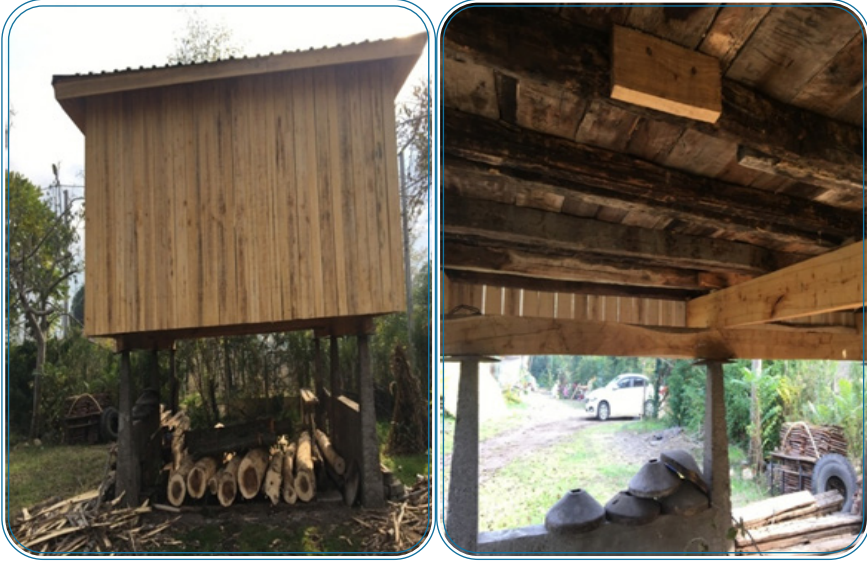
Resim 9: Gökçeada Mahallesi Yeni Serenderi Arka Cephe ve Ahşap Döşeme
