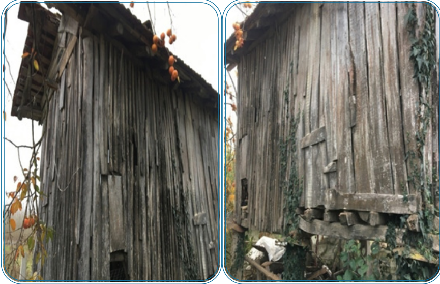
Resim 19: Evcı Mahallesi Eski Serenderi Yan Cephe
