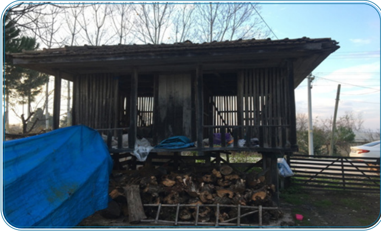
Resim 35: Elmaköy Mahallesi Serenderi Ön Cepheden Görünüm
