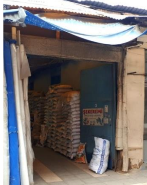
Foto.14: Buğday Hanı güney kapısı
