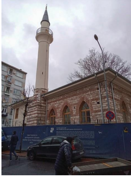
Şekil 10: Saha çalışmaları kapsamında 18.03.2023 tarihinde fotoğrafladığımız Muhsine Hatun Camii (Güney Cephesi) (Mahmut Demirdil, 2023).
