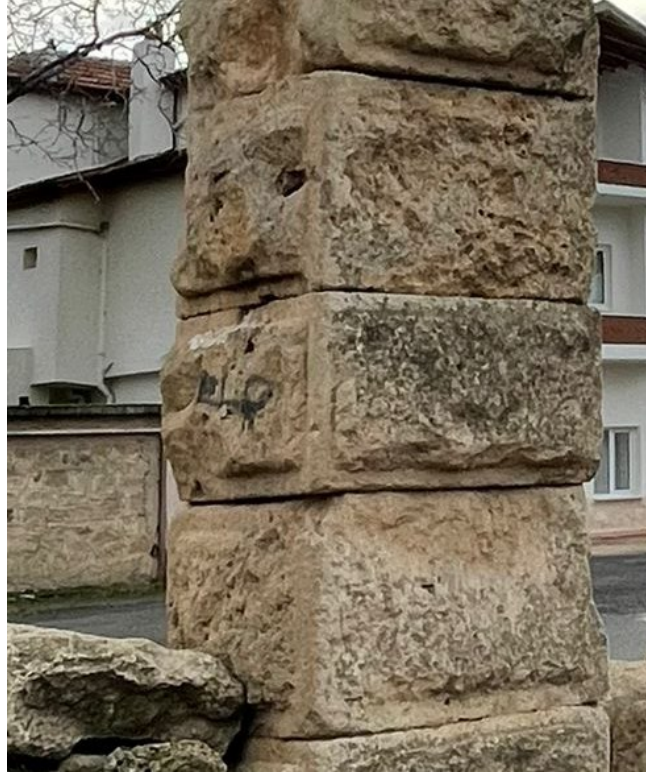
Resim 7. Kemer yapımında kullanılan Gökbez Formasyonu'ndan getirilen bosajlı kayaç (Tyana Kazı Arşivi)
