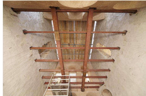
Şekil 19. Ara kat çelik uygulaması 35
