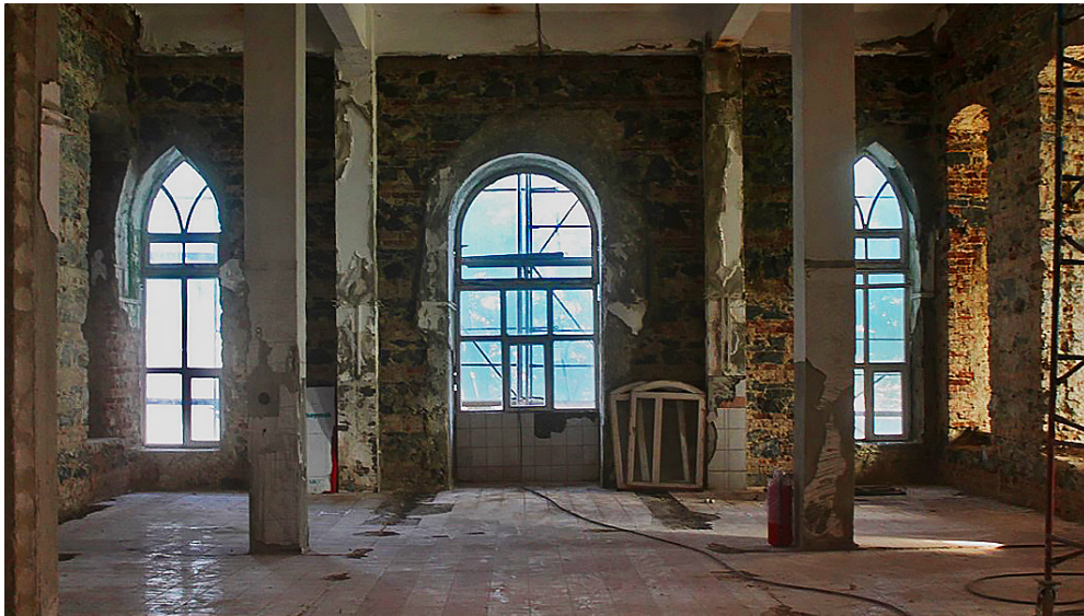
8 İç mekânın muhdes beton kolon kirişi
