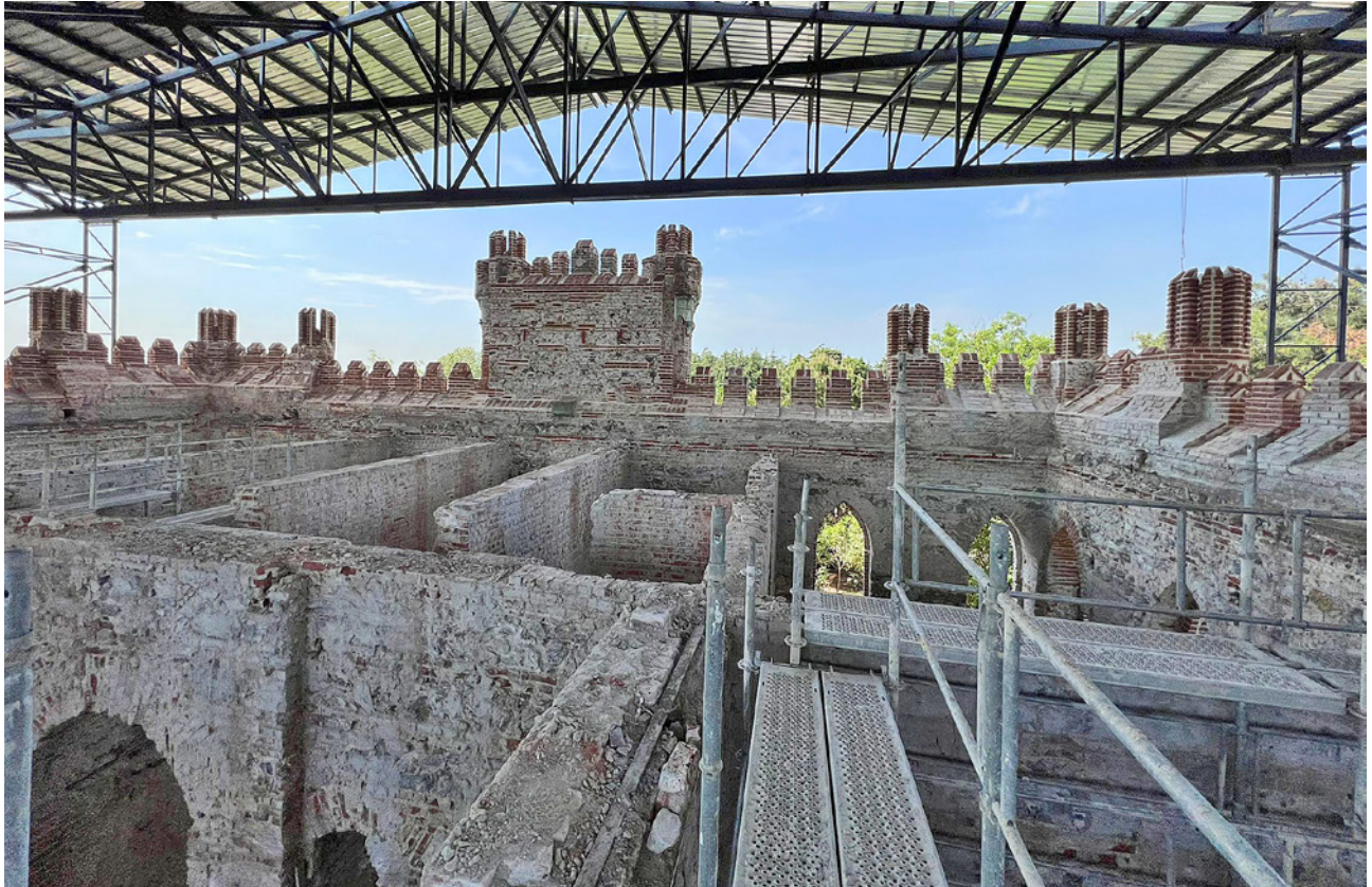
14 Betonarme çatı tabliyesinin kesilerek uzaklaştırılması
