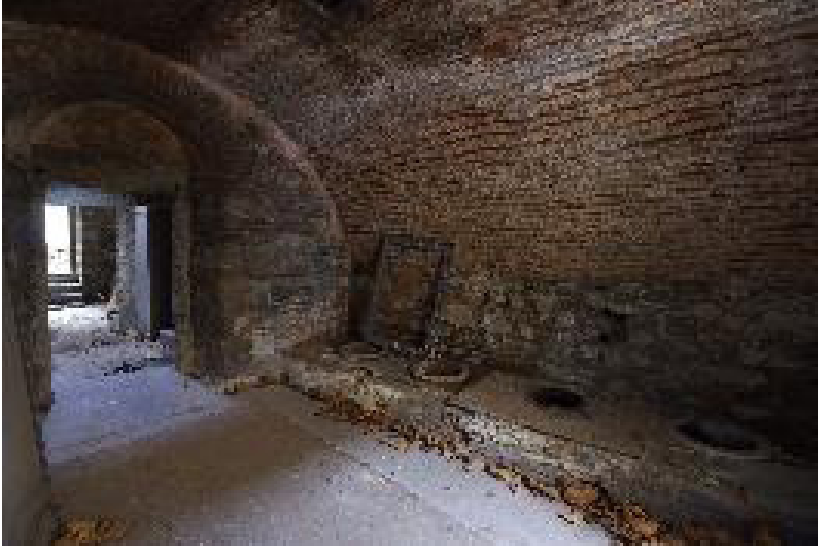
Şekil 33. Yağ depoları tonoz örtüsü
