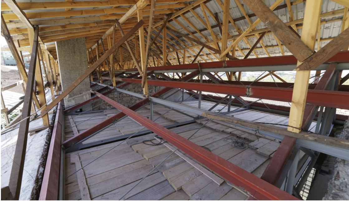
Şekil 17. Çelik çatı güçlendirme uygulaması 32
