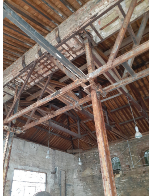
Şekil 12. Sonradan açılan açıklık ve çelik profiller
