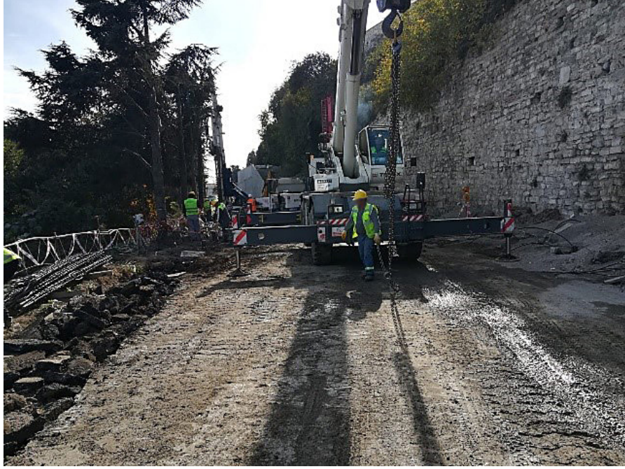
Resim 3. Güçlendirme çalışmalarından bir kesit (Eril, 2022)
