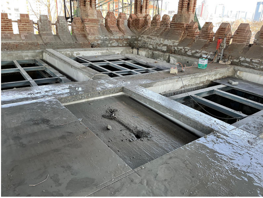
13 Betonarme çatı tabliyesinin kesilerek uzaklaştırılması
