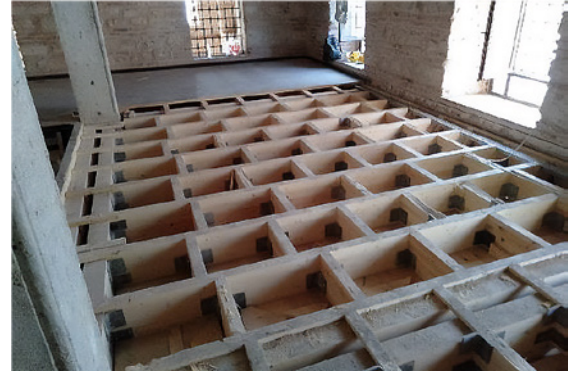
Şekil 4. Mevcut ahşap döşeme sistemi
