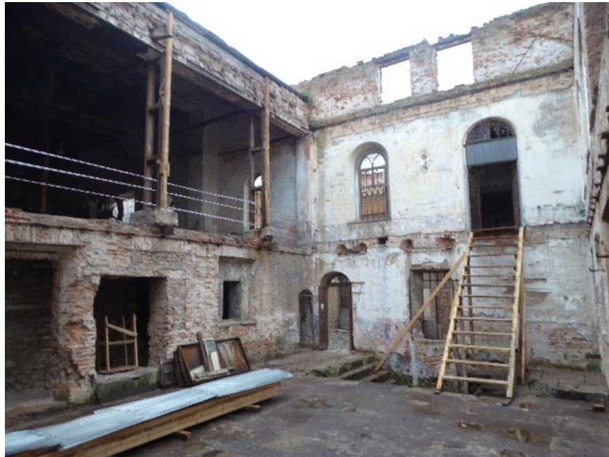
Şekil 21. Transmasyon ve Sikkehâne mahalleri arasında görülen muhdes açıklık ve çelik profiller
