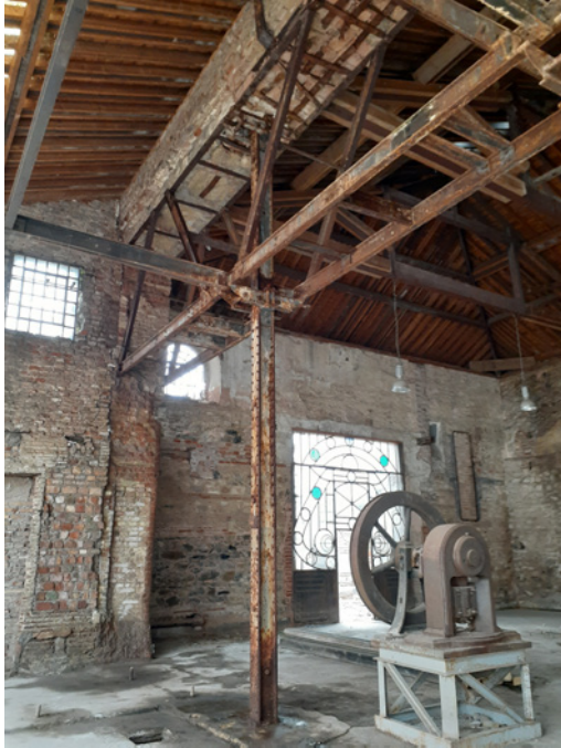
Şekil 12. Sonradan açılan açıklık ve çelik profiller
