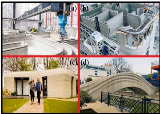
Şekil 2. 3D yazıcı ile beton üretimi ve kullanım alanları (a)Büyük ölçekli 3DCP (Anjuma ve diğ., 2017), (b)PERI/COBOD ve Mense-Korte'de iki katlı bir 3DPC evi, (c)2021'in başlarında Hollanda'nın ilk 3DP evi
