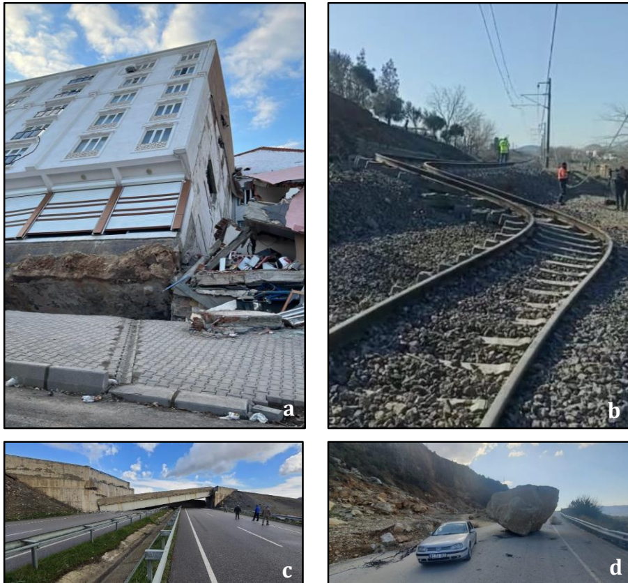
Şekil 6. 06 Şubat 2023 Depremlerinde Oluşan Afetin Boyutları ve Kentsel Etkilerine Örnekler. Adıyaman Gölbaşı İlçesinden Zemin Sıvılaşmasına Bağlı Bir Yapı Hasarı (a). Kahramanmaraş Şekeroba Tren Yolunun Fay Tarafından Ötelenmesi (b). Gaziantep Nurdağı İlçesinde Deprem Sırasında Çöken Bir Otoyol Üst Geçiti (c). Hatay Döver Köyünde Kaya Düşmeleri (d).
