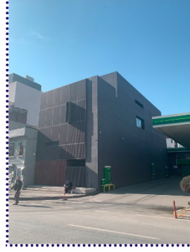
Fotoğraf 1.3: Opak cephe kurgusu, iç mekân hakkında fikir vermese de çevreyle uyumlu ölçeği ve 'çağdaş' malzeme kullanımıyla yapı, kentlide tekinsizlik uyandırmamıştır.
