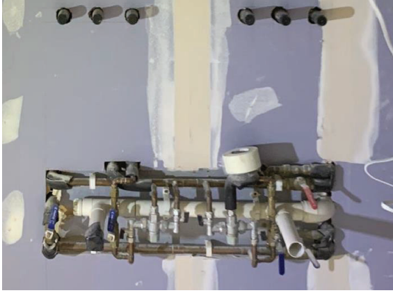
Şekil 25. Revit yazılımında tasarlanan banyo içi temiz su tesisatı uygulaması (SAINA Danışmanlık Mühendisliğin izniyle)
