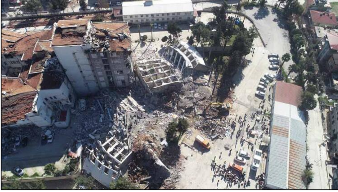
Foto 1. Depremde Yıkılan Antakya Eski Devlet Hastanesi ( https://www.dha.com.tr ).
