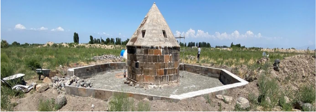
Res. 21: Kolikent Kümbeti Çevre Düzenleme Onarım Görünüşü (Ş. Öztürk-2021)
