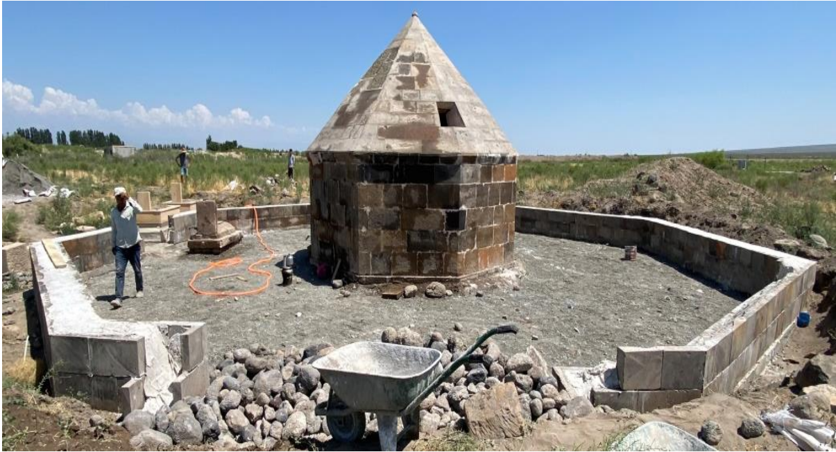
Res. 22: Kolikent Kümbeti Çevre Düzenleme Onarım Görünüşü (Ş. Öztürk-2021)
