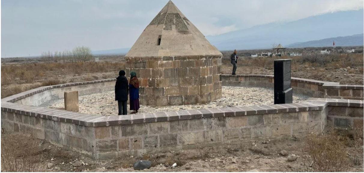
Res. 25: Kolikent Kümbeti Onarım Sonrası Genel Görünüşü (Ş. Öztürk-2021)
