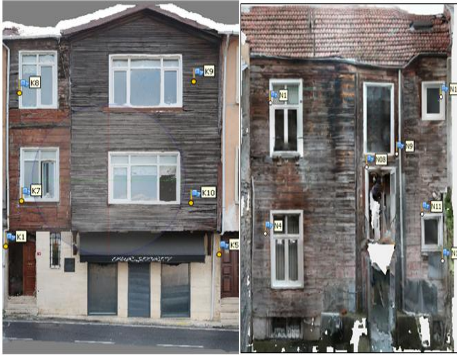
Şekil 5. Yapının ön ve arka görünümünde bulunan obje noktaları
