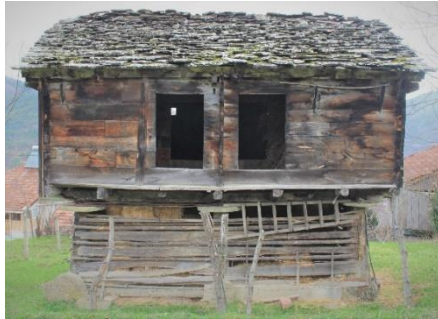
Foto. 42. 5 Numaralı Ambar ön cephesi
