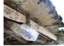
Foto. 112. Otmanlı Çeşmesi saçakta destek kavilası
