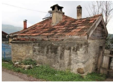
Foto. 81. 7 Numaralı İkiz Fırın sağ yan ve arka cephe
