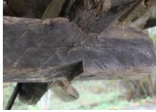
Foto. 108-111. Otmanlı Çeşmesi ahşap kermeli uç birleştirme ayrıntıları
