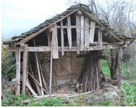
Foto. 9. 1 Numaralı Ahır - Ağıl - Samanlık yapısı ön cephe
