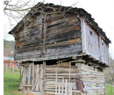
Foto. 44. 5 Numaralı Ambar arka ve sağ yan cephe
