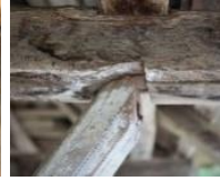
Foto. 108-111. Otmanlı Çeşmesi ahşap kermeli uç birleştirme ayrıntıları
