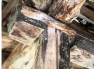
Foto. 104-107. Otmanlı Çeşmesi ahşap kanallı birleştirme ayrıntıları
