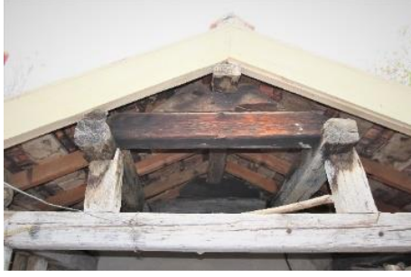
Foto. 83. 7 Numaralı İkiz Fırın çatı ayrıntısı (kanallı birleştirmeler)
