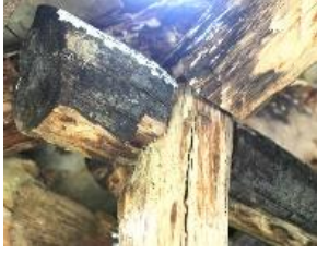
Foto. 104-107. Otmanlı Çeşmesi ahşap kanallı birleştirme ayrıntıları
