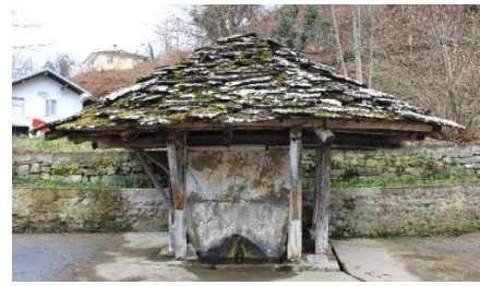
Foto. 96. Otmanlı Çeşmesi batı cephe
