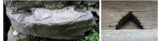
Foto. 35-36. 3 Numaralı Ambarın ön cephesinde bulunan ambara çıkış sağlayan ahşap sey-yar dayama merdivenin konulduğu taban taşı ve cephede pencere açıklığı ayrıntısı
