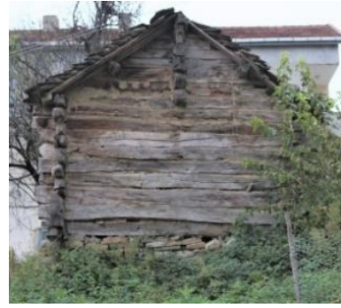
Foto. 10. 1 Numaralı Ahır - Ağıl - Samanlık yapısı arka cephe
