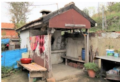
Foto. 68. 4 Numaralı Fırın ön ve sol yan cephe
