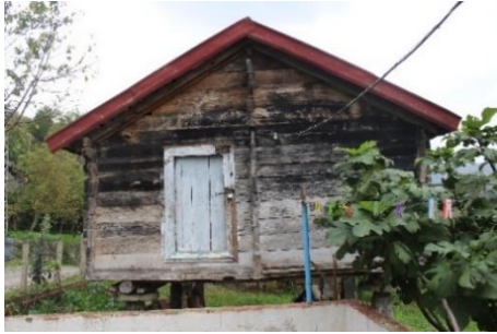
Foto. 30. 3 Numaralı Ambarın ön cephesi
