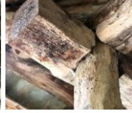
Foto. 104-107. Otmanlı Çeşmesi ahşap kanallı birleştirme ayrıntıları
