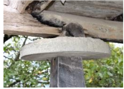
Foto. 47-49. Aynı ambarın sağ yan cephesi (solda) duvar ve direk başlık ayrıntıları (orta ve sağda)
