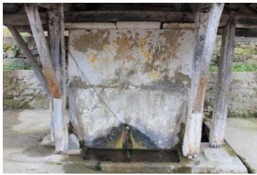
Foto. 97. Otmanlı Çeşmesi batı cephe
