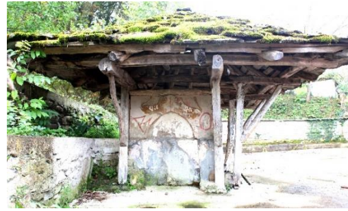
Foto. 93. Otmanlı Çeşmesi kuzey cephe
