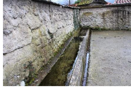
Foto. 89. Köy Meydanında bulunan 1. çeşme
