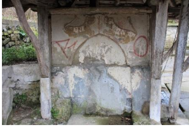
Foto. 94. Otmanlı Çeşmesi kuzey cephe
