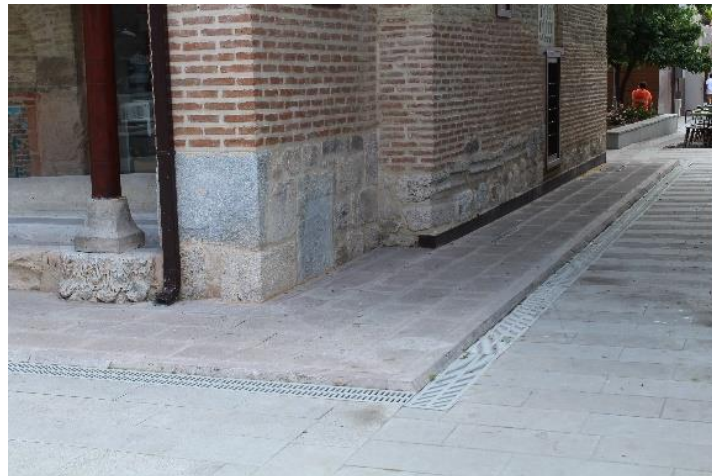
Fotoğraf 9. Drenaj uygulaması.
