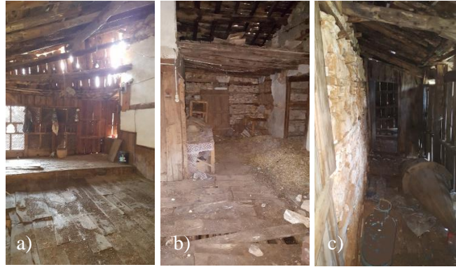
Şekil 24. Yapının sofa (a), sedir (a) ve aralık kısmından helaya bakış (a) görselleri.
