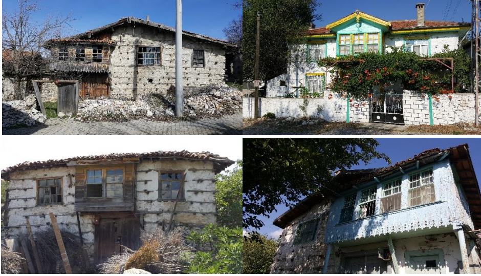
Şekil 11. Emiraşıklar mahallesi'nde bulunan tescile değer konutlar.
