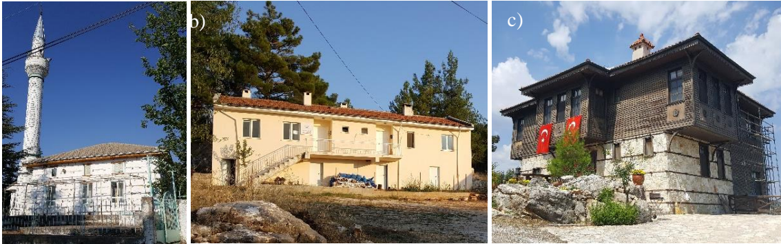
Şekil 8. Emiraşıklar camii (a), sağlık ocağı binası (b) ve otel (c)
