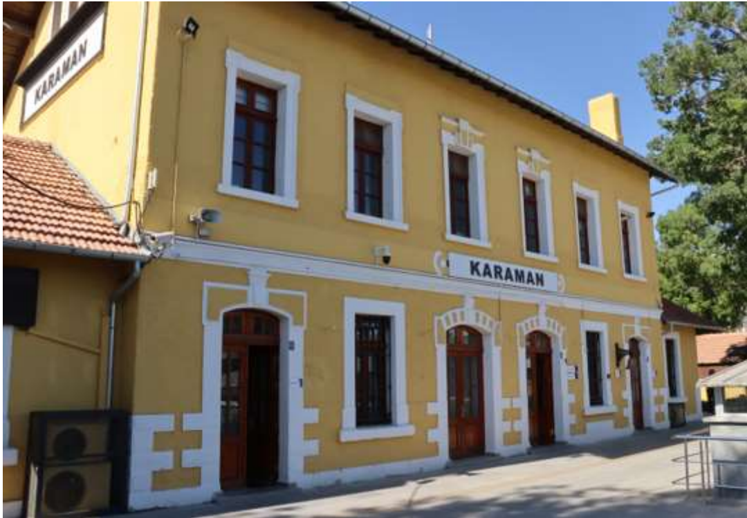
Şekil 12. İstasyon binasının kuzey cephesi (Yazar Arşivi, 2023)
