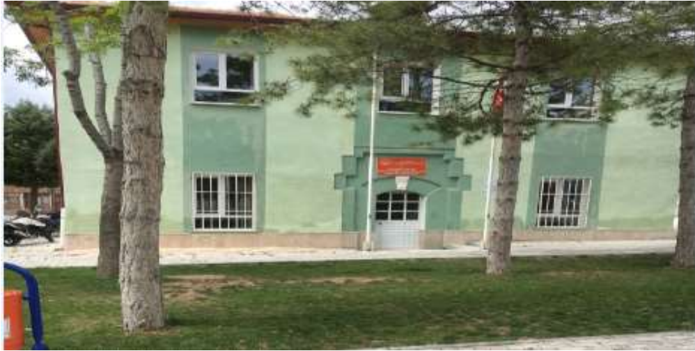
Şekil 8. Redif Kışlası'nın güney cephesi (Yazar Arşivi, 2023)
