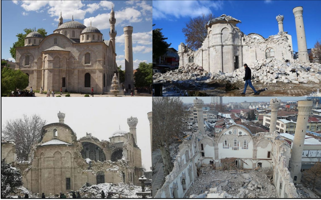
Fotoğraf 3. Yeni Cami'nin Depremden Önce ve Sonraki Hali
