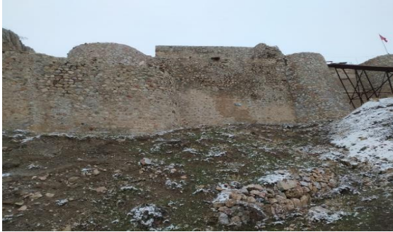
Fotoğraf 4. Güney Sur Duvarı ve silindirik burçlar.
