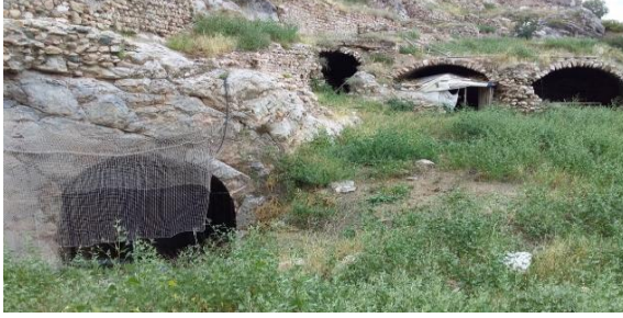
Fotoğraf 12. Tonoz yapılar (Zindan).
