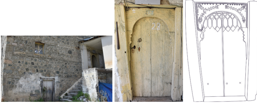
Görsel 14. Merdivenler ve Harim Giriş Kapısı
