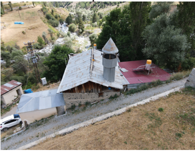
Görsel 6. Yapının Kuzey Cephesi
