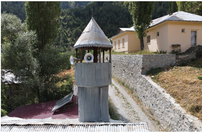
Görsel 31. Minarenin Seren Diređi, Giriş Kapısı, Merdivenleri ve Dıştan Görünümü
