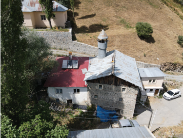
Görsel 4. Yapının Güney Cephesi
