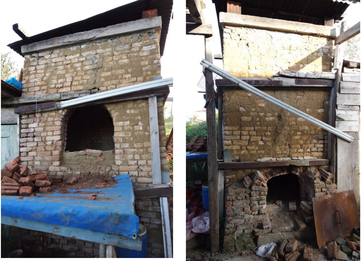
Fotoğraf 5: Ünye fırını, solda fırının yan tarafında bulunan yükleme kısmı, sağda fırının ön kısmındaki ateş yakma bölümü.
