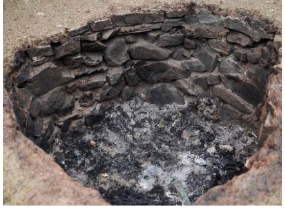
Fotoğraf 9: Dölek köyü geleneksel çömlek fırını dıştan ve içten görüntüsü.
