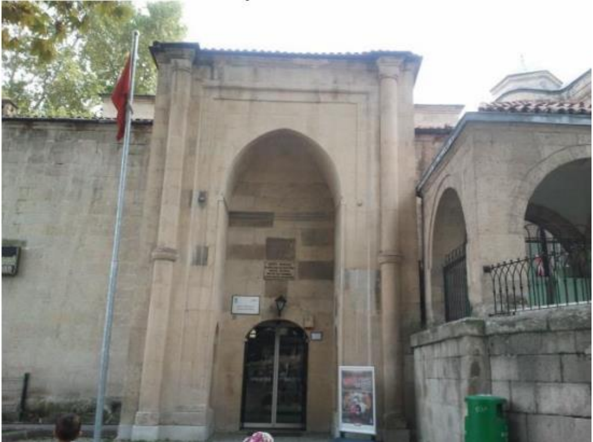
Vacidiye Medresesi'nin Giriş Kapısı (Erden, 2015: 218)
