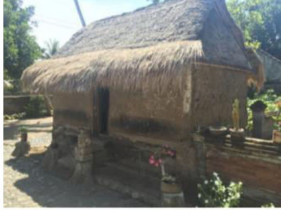
Şekil 19. Çatı, duvar ve temellerde doğal malzemelerin (ahşap, bambu ve kuru saman) kullanılması (Aryani, 2013)
