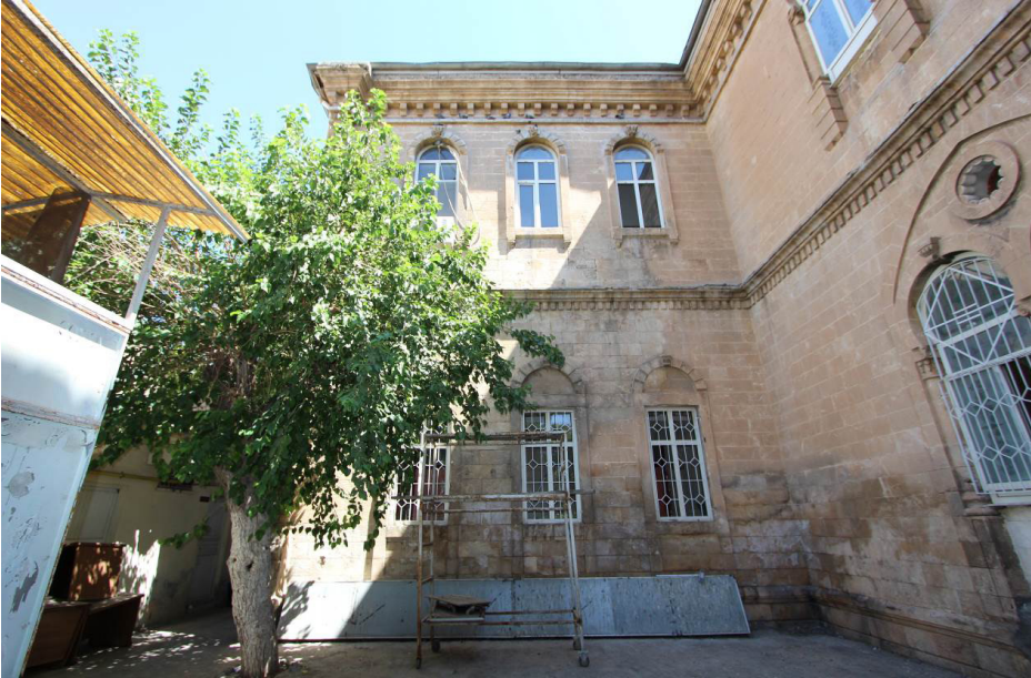
Fotoğraf 6: Şanlıurfa Hamidiye Hastanesi Batı Kanadın Güney Cephesi
