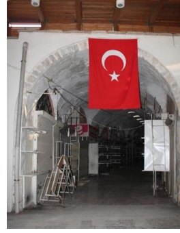
Fot.10: Maraş Kapalı Çarşı, güney (Bakırcılar Çarşısı) kapısı
