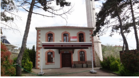
Fot.67: Yanıkađıl Köyü Camisi, giriş cephesi (Baçaru, 2023)
