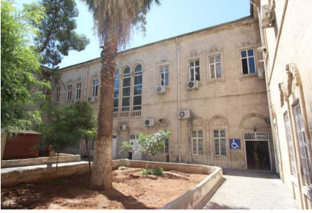
Fotoğraf 8: Şanlıurfa Hamidiye Hastanesi Ana Kanadının Kuzey Cephesi
