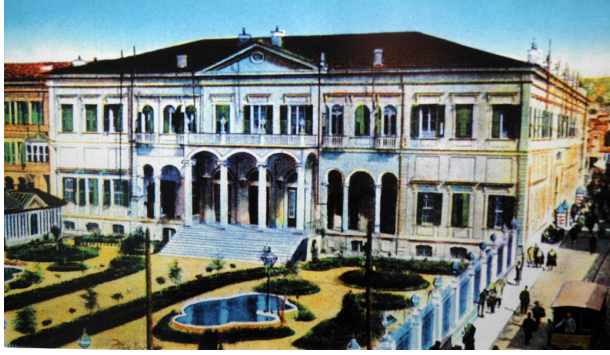
Fot. 6: İzmir Hükümet Konağı Müstemilatı ve Bahçesi 64
