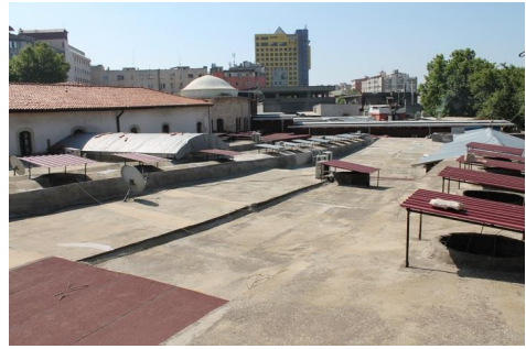
Fot.14: Maraş Kapalı Çarşı, örtü
