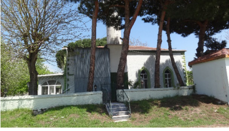
Fot.60: Uzunhacı Köyü Camisi, batı cephesi (Baçaru, 2023)
