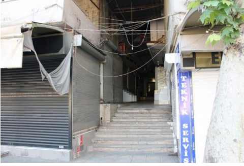
Fot.11: Maraş Kapalı Çarşı, batı cephenin güney köşesine açılan kapı
