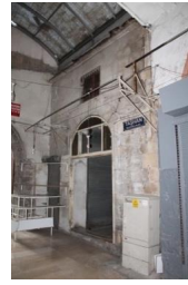
Fot.8: Alacacılar Arastası, kuzey kapısı
