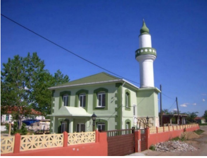
Fot.87: Naıbyusuf Köyü Camisi 164
