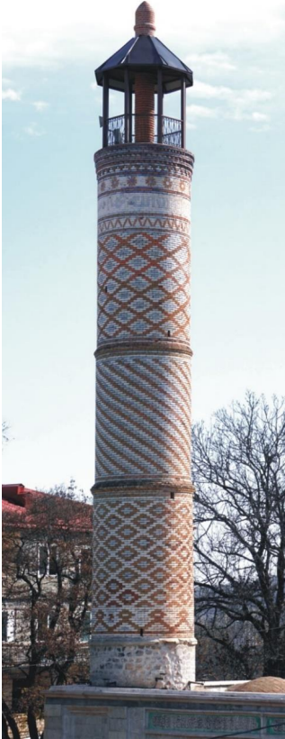
Res.13- Kuzeydoğu minaresi
