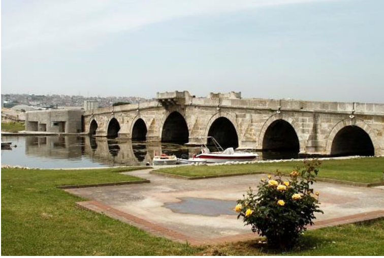
Fot. 3: Köprü mansap cephesi, İstanbul yönündeki birinci köprü, seyir terasları.
