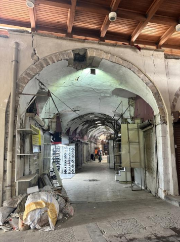
Fot.31: Maraş Kapalı Çarşısı, 6 Şubat 2023 depremi sonrası güney (Bakırcılar Çarşısı) kapısı (İ. Demirkol Bayrak)
