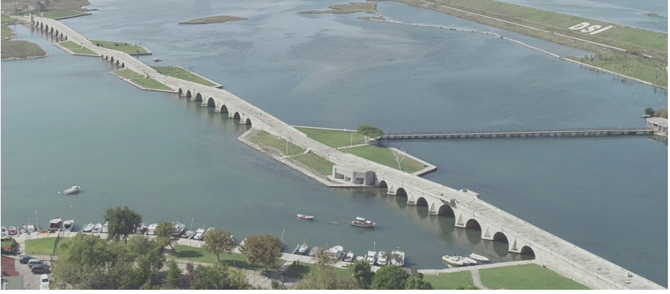
Fot. 1: Büyükçekmece Köprüsü'nün mansap cephesi, doğudan genel görünüm.
