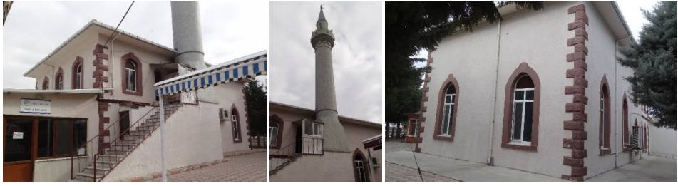
Fot.36.: Yulaflı Köyü Camisi, kuzeybatıdan görünüş/minare/kible duvarı (Baçaru, 2022)
