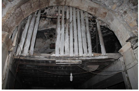
Fot.24: Maraş Kapalı Çarşı, Alacacıklar Arastası, güney bölüm örtü sisteminde takviye kemeri
