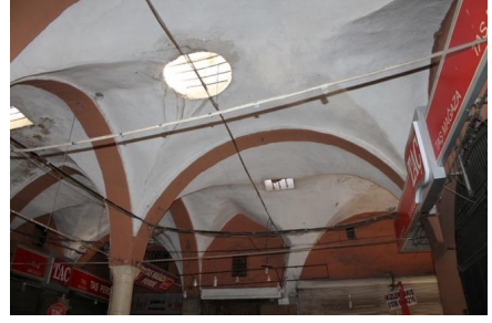
Fot.28: Maraş Kapalı Çarşısı, Bedesten girişi önündeki holün çapraz tonoz örtüsü
