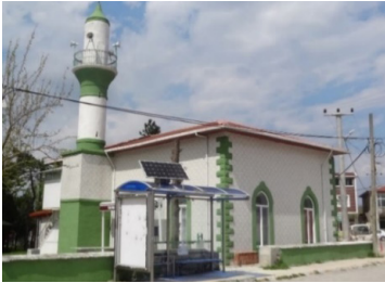
Fot.41: Bahçeagil Köyü Camisi, güneyden genel görünüş (Baçaru, 2023)
