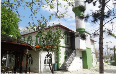
Fot.39: Bahçeagil Köyü Camisi, kuzeydoğudan görünüş (Baçaru, 2023)
