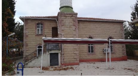
Fot.20: Şahpaz Köyü Camisi, batı cephesi (Baçaru, 2022)
