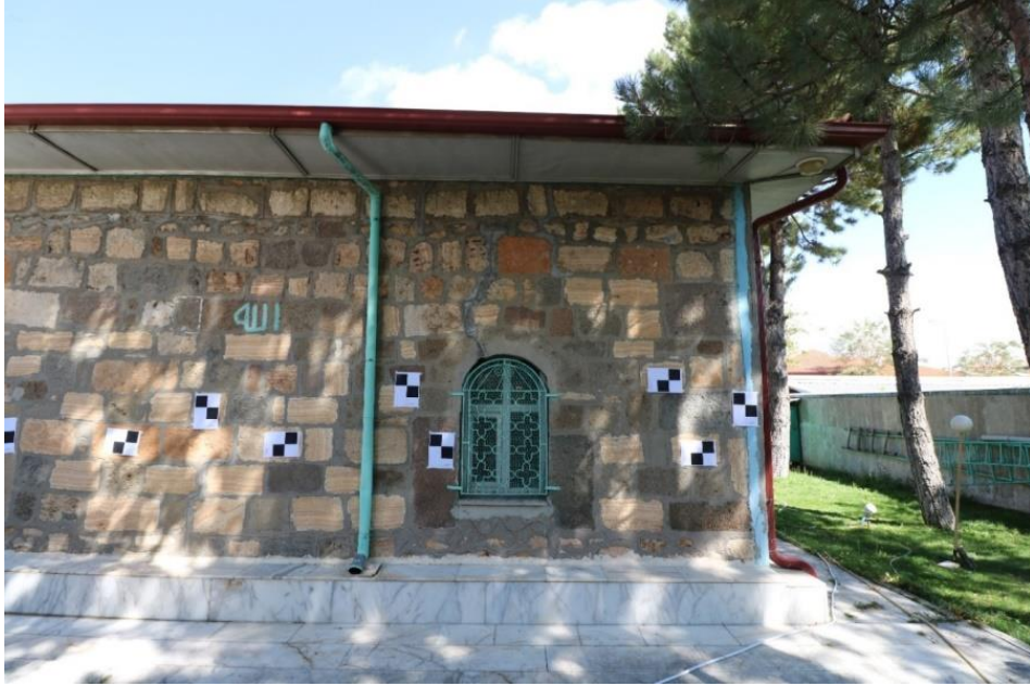
Şekil 5. Yapının Güney Cephesi Görünüşü (Kaynak: Kültür İnşaat Restorasyon)
