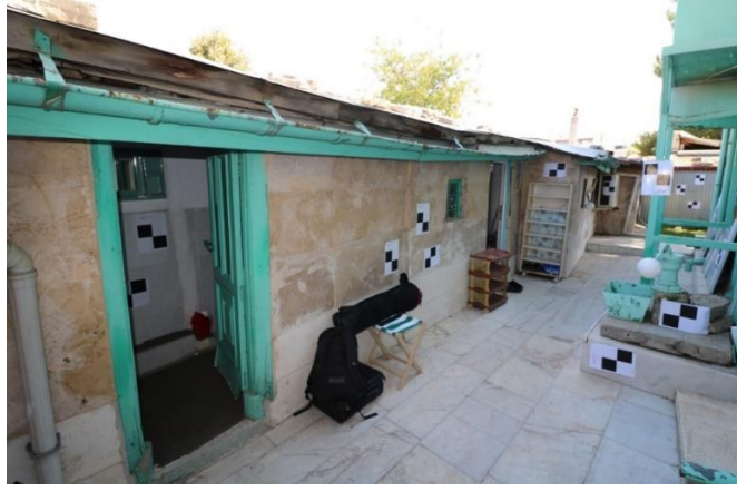
Şekil 7. Bahçede Yer Alan Tuvaletten Genel Görünüş (Kaynak: Kültür İnşaat Restorasyon)
