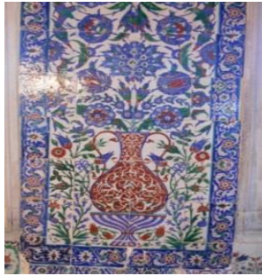
Resim 42: İstanbul Takkeci İbrahim Ağa Camii
