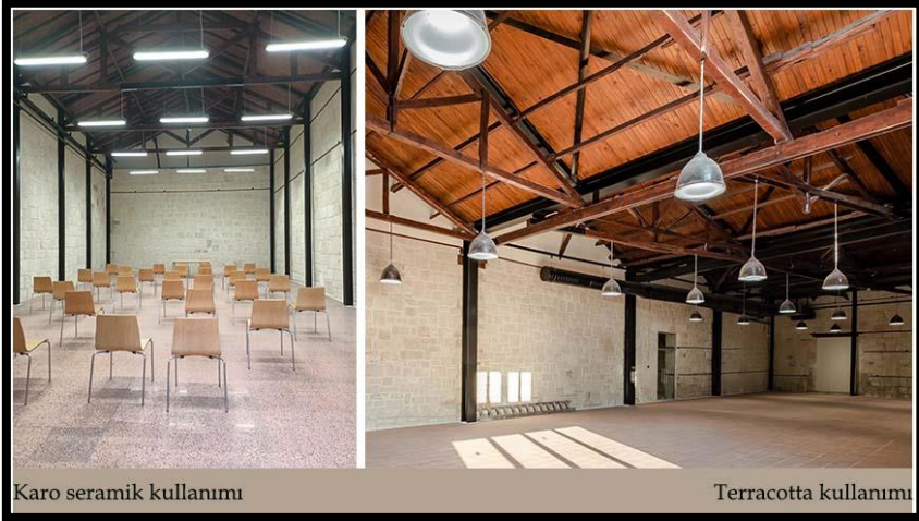
Şekil 11: Döşeme kaplamalarının ahşap, taş, çelikle uyumlu kombinasyonu (Kaynak: https://www.arkitera.com ,düzenlenmiştir.)
