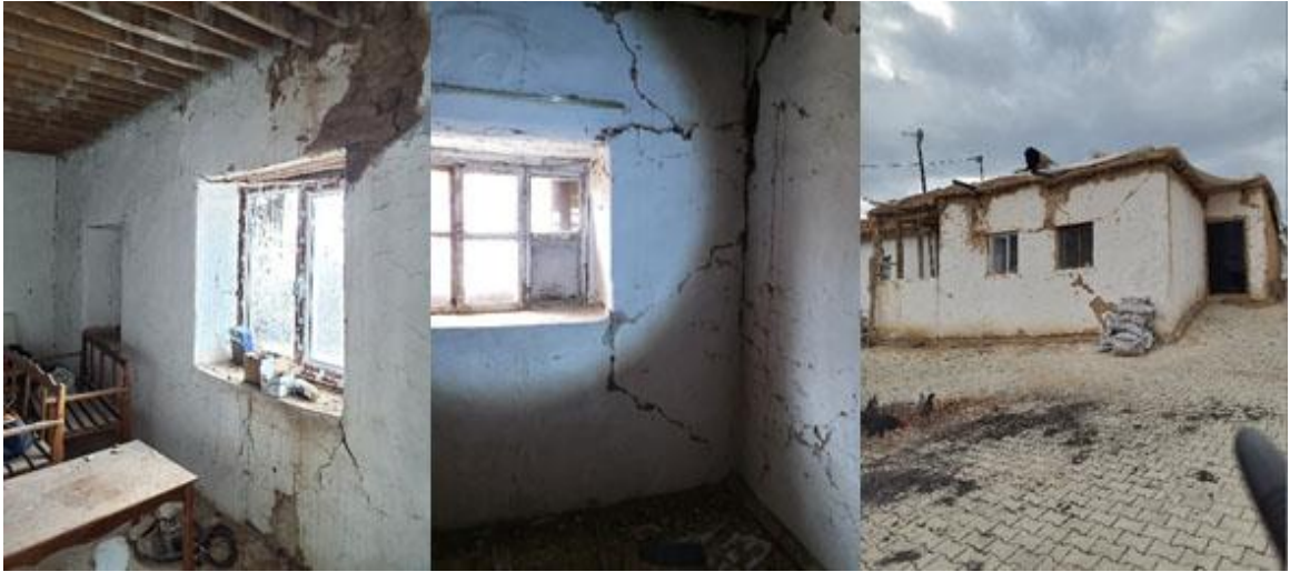
Şekil 13. Yiğma yapılarında B tipi orta hasar örneği, Çayırköy Mahallesi (İnş. Müh. Kadir Bostancı Arşivi)
