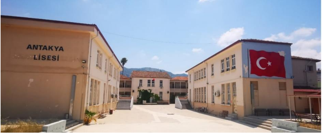
Şekil 3. Antakya Lisesi genel görünümü
