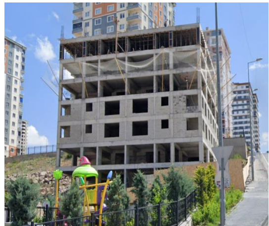
Şekil 7. Betonarme çerçeve sistem bina örneği
