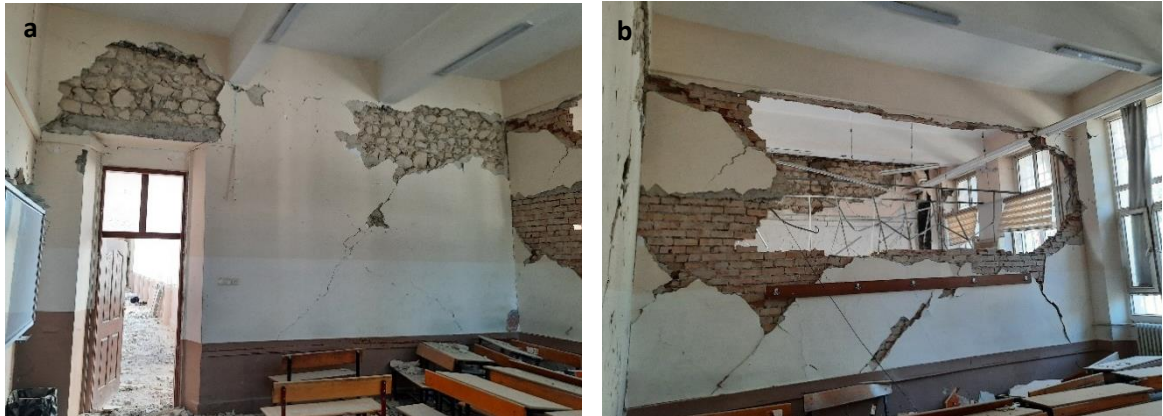
Şekil 12. Taşıyıcı iç duvarlarda farklı malzeme uygulamalarına bağlı hasar düzeyleri a) moloz taş b) yatay delikli pişmiş toprak tuğla
