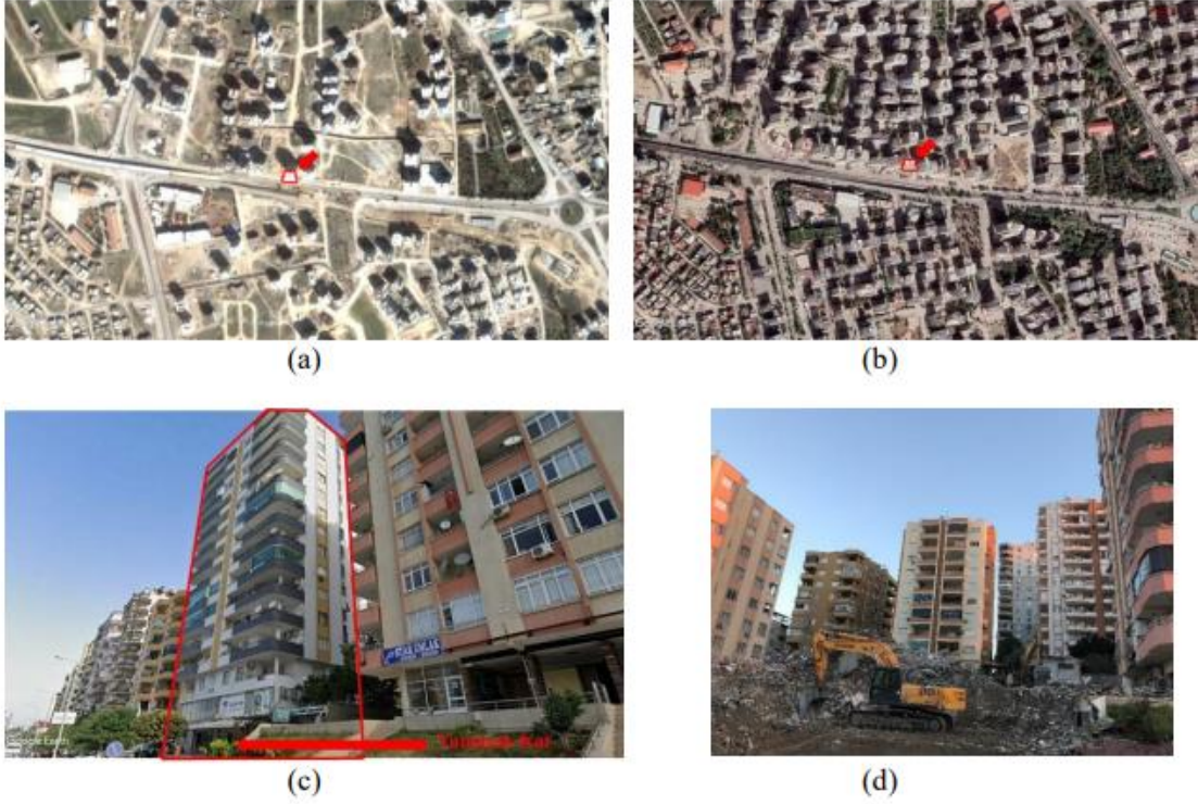
Şekil 17. (a) ve (b) Adana'daki Turgut Özal Bulvarı'nın deprem öncesi ve sonrasına ait uydu görüntüleri (BTÜ, 2023, s.46) (c) ve (d) ise bulvar üzerinde yer alan Kubilay Apartmanının deprem sonrası görselleri (BTÜ, 2023, s.46)
