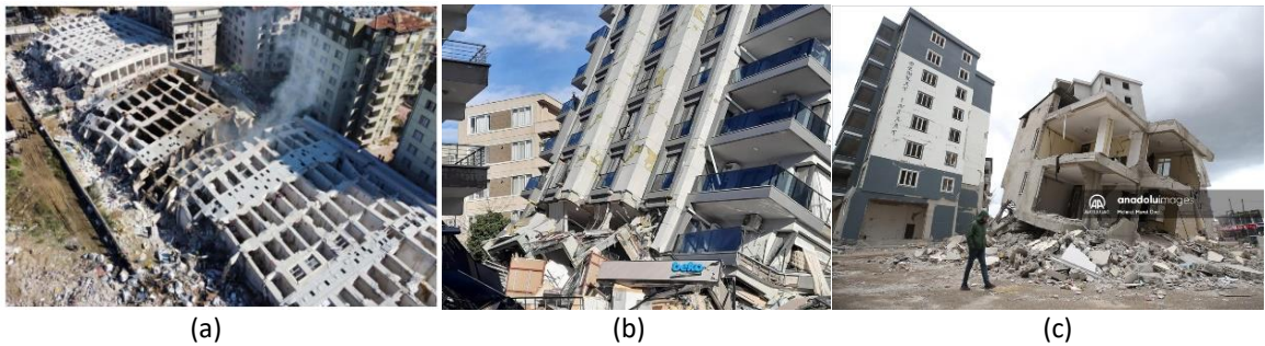
Şekil 13. 6 Şubat 2023 Maraş depremi sonrası deprem bölgelerinde yana yatarak hasar alan binalar (a) Rönesans Rezidans, Hatay-Antakya (TMMOB, 14 Şubat 2023, s.5) (b) Cebrazil Mahallesi, Atatürk Caddesi, Hatay- Antakya (İHA, 2023) (c) Kahramanmaraş (Önel, 2023)
