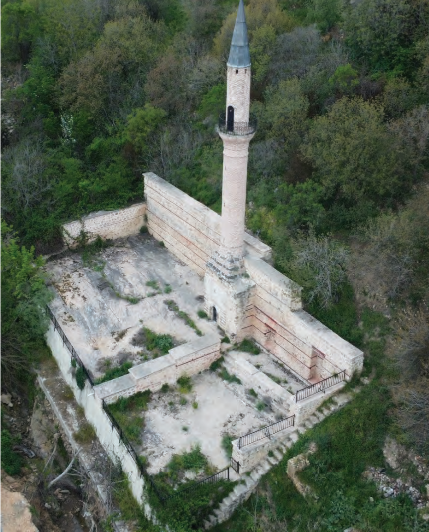
G. 11: Osman Gazi Camii'nin koruma-onarım yapılmış hâli (Eskişehir Kültür ve Tabiat Varlıklarını Koruma Bölge Kurulu Arşivi 11.00.41 No.lu Dosya 35 )
