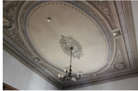
G. 24: Zemin kat güneybatı köşe odası tavanı (M. Dündar, 2020)
