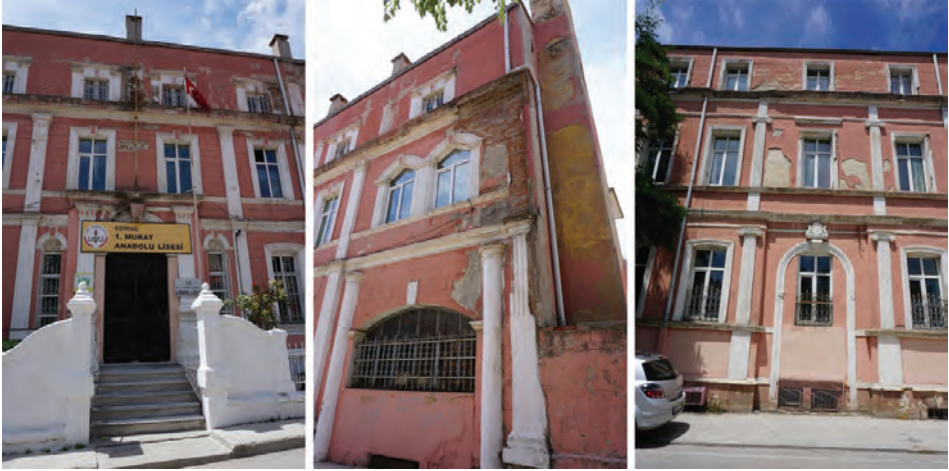
G. 19: I. Murat Anadolu Lisesinin doğu cephesindeki ana giriş kapısı (Sağ); doğu cephesinin kuzey ucundaki kapatılmış yuvarlak kemerli eski giriş (Orta); kısa kolunun güney cephesindeki pencereye çevrilmiş eski giriş (Sol) (M. Arslan Çinko, 2018)
