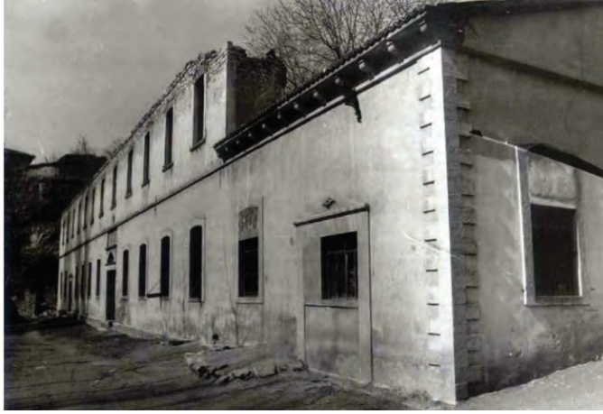
G. 1: Safranbolu’daki eski tabakhane binası (Sarıtunç, “Safranbolu’da Kültür Hazinesi Olarak Tabag Ahmet Bey Tabakhanesi ve Dericilik Geleneği”, 56)
