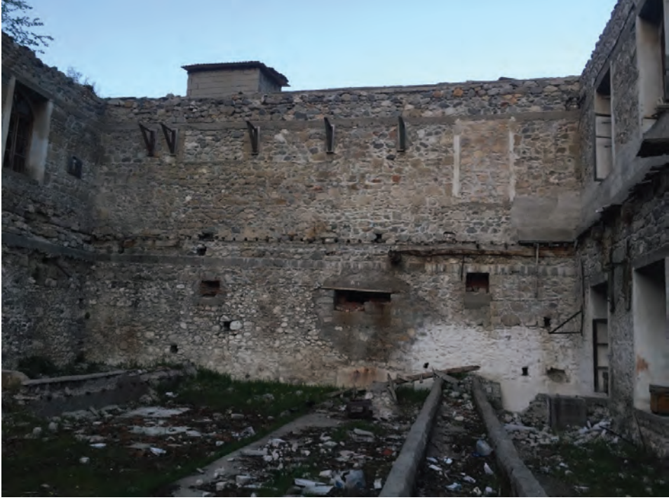
G. 12: Beden duvarlarında yer alan metal ekler ve askılar (Özgün dönem kütesinin dönem eki yapı ile arasında kalan doğu duvarına batı yönünden bakış) (Ayşe Betül Gökarşlan, 2023)
