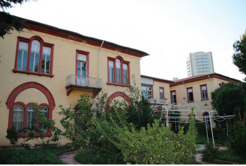
G. 12: Yapının Kuzeydoğu Cephesi (Özkan, 2021)
