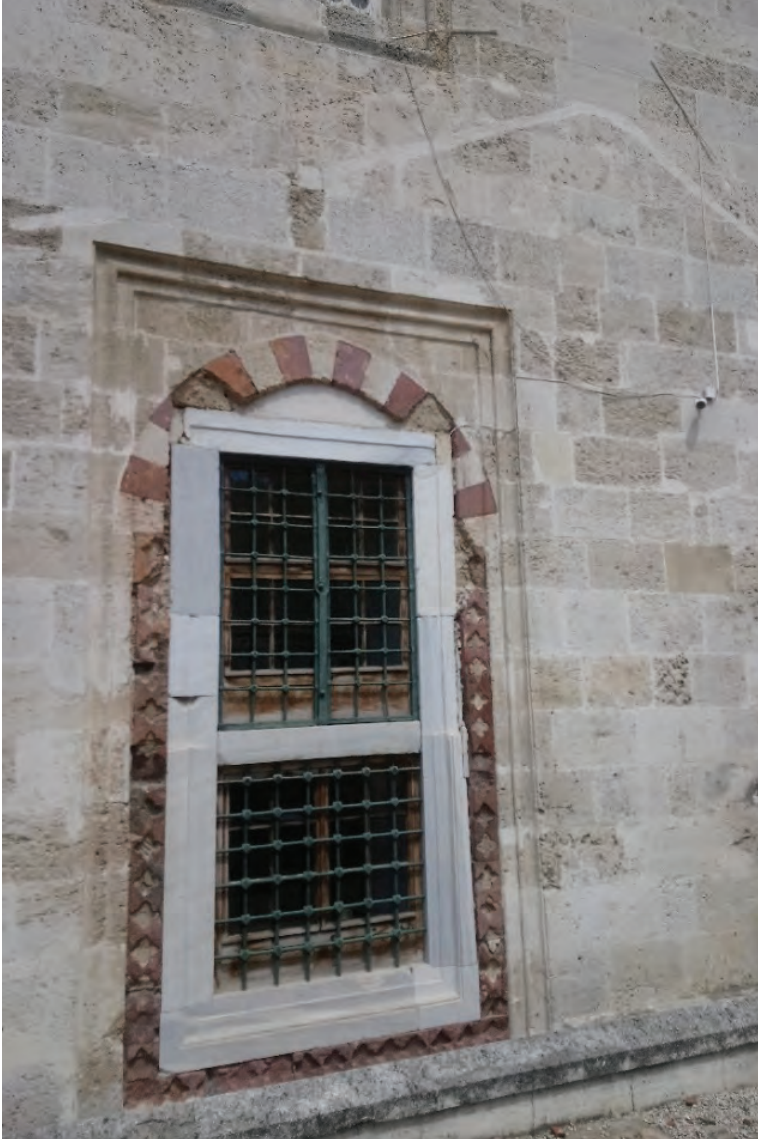
G. 11: Hünkâr kasrı ve giriş kapısı olarak değiştirilen pencere ile üzerindeki saçak izi (N. Ç. Akçıl Harmankaya, 2023)
