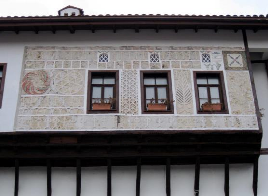
Resim 25. Mektepçiler Evi (Safranbolu Medresesi) Cephe
